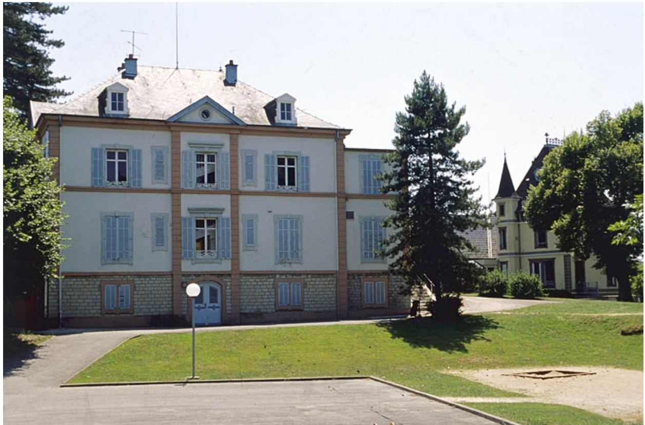
Façade ouest du logement patronal.
