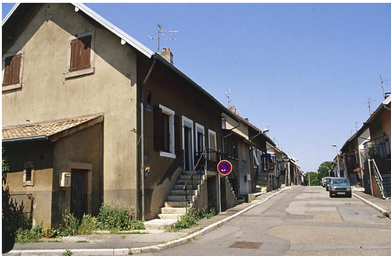
Logements ouvriers rue de la République.
