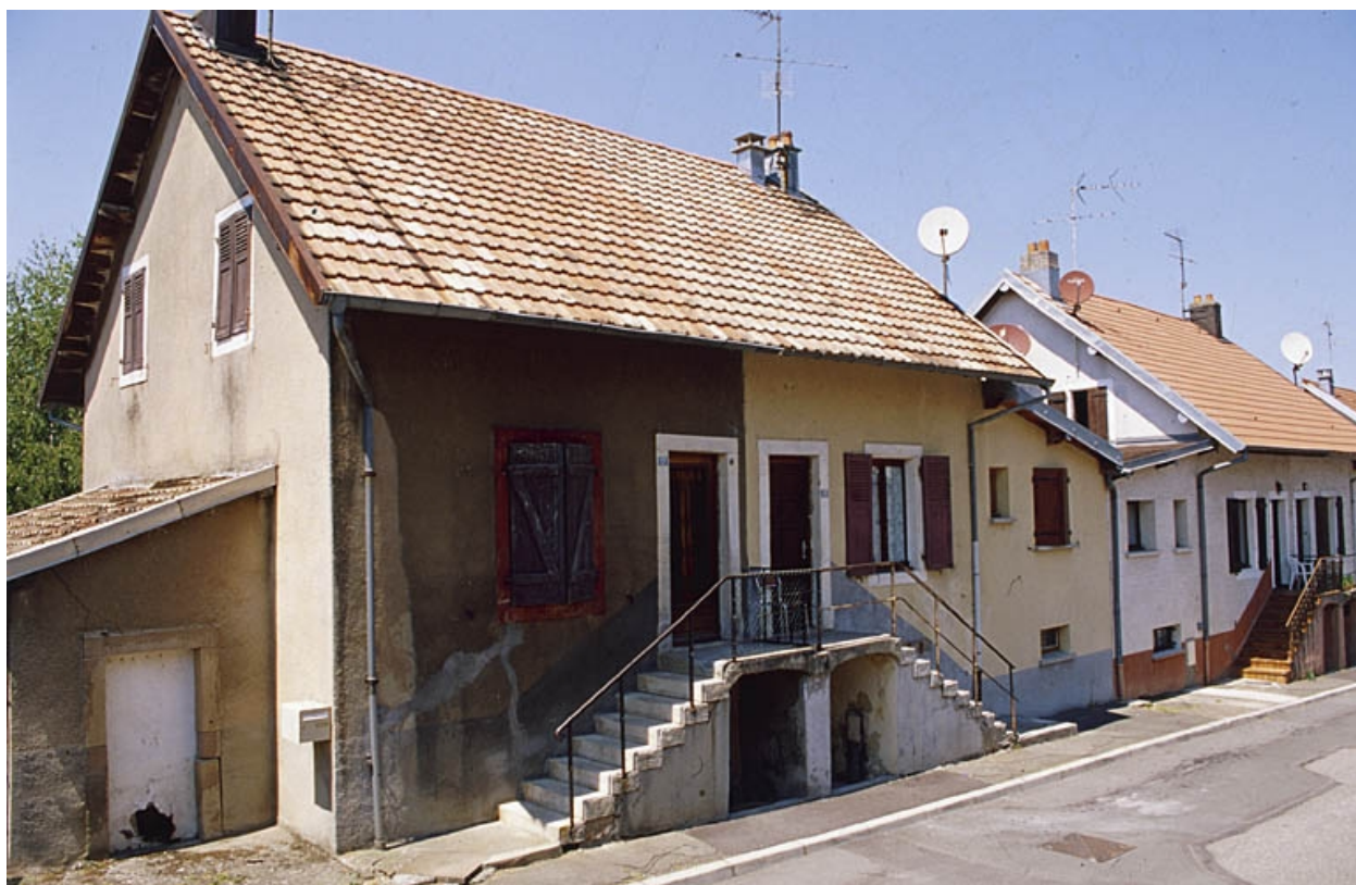
Logement ouvrier double.
