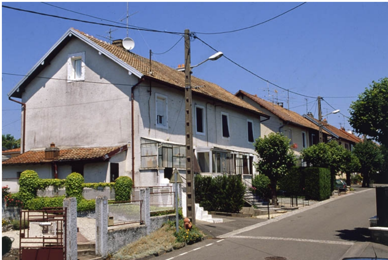
Logements ouvriers rue de Lattre de Tassigny.
