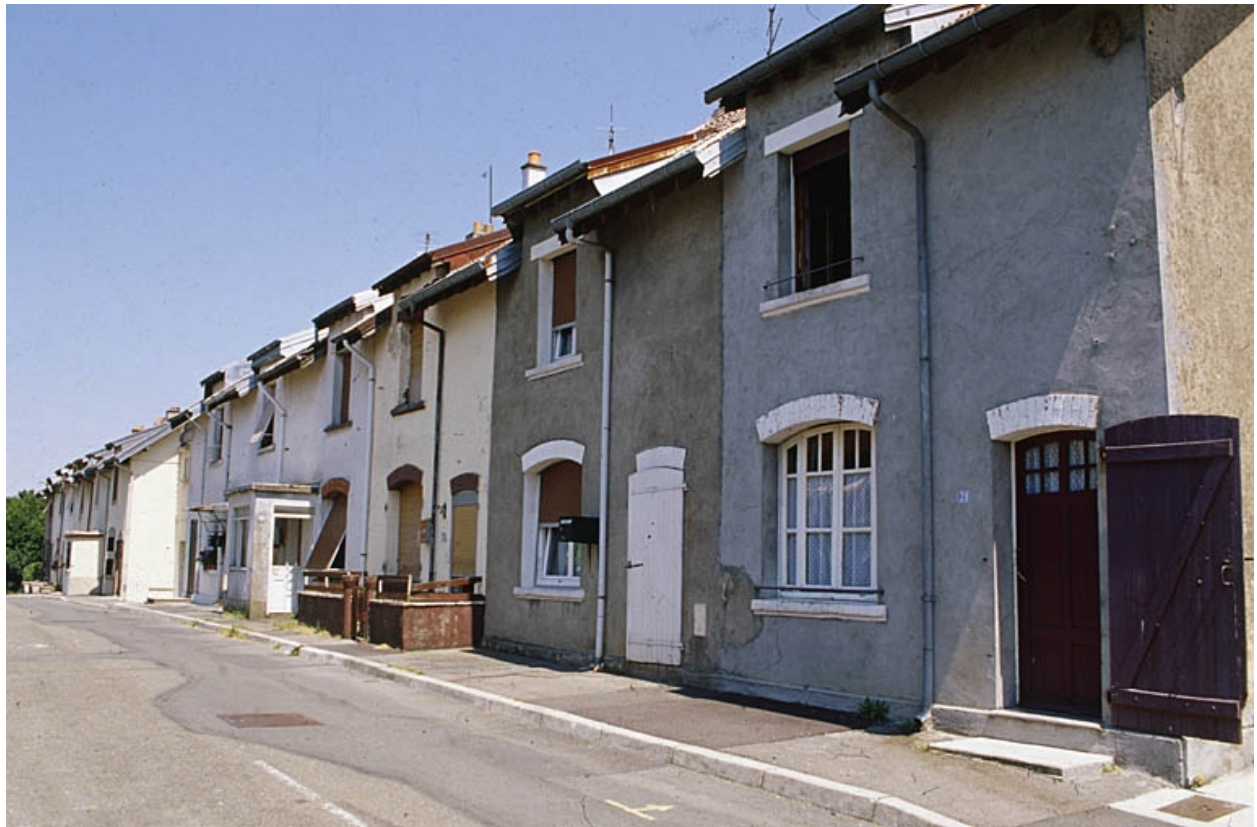
Rue d'une cité ouvrière.
