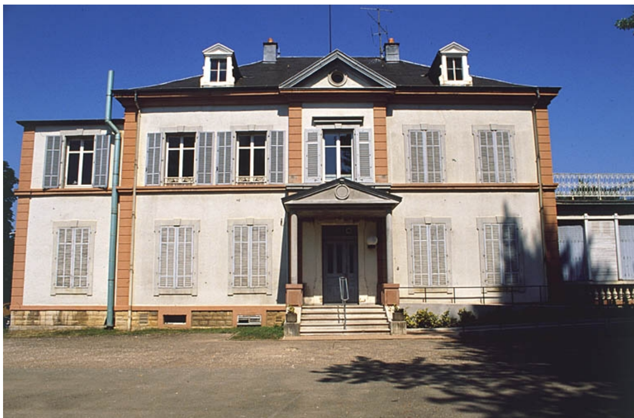
Façade est du logement patronal.
