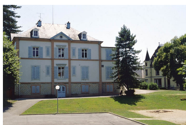
Façade ouest du logement patronal. Phot. Yves Sancey IVR43_20009000568ZA
