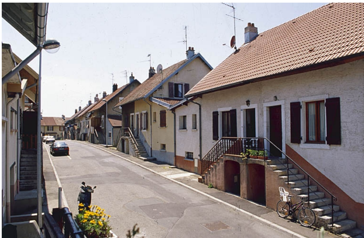
Logements ouvriers rue de la République.
