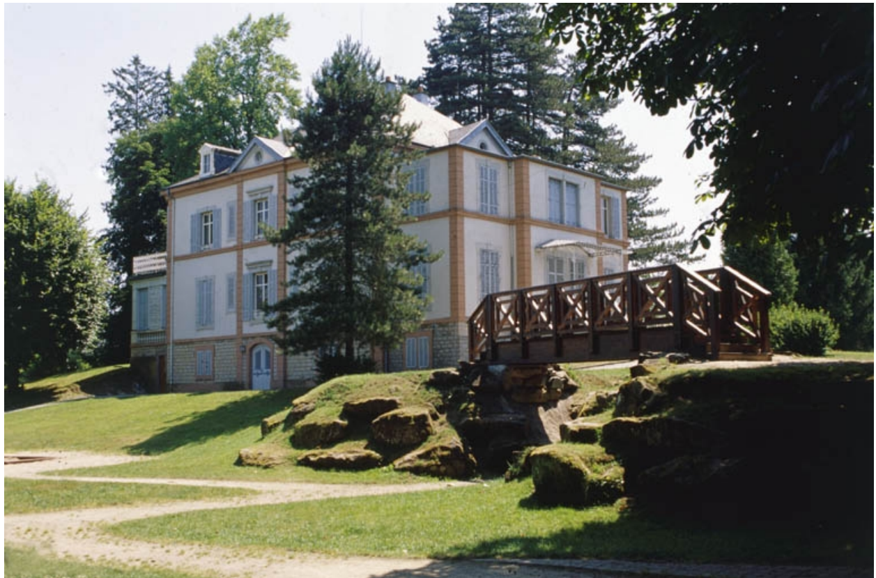
Le logement patronal depuis l'ouest.
