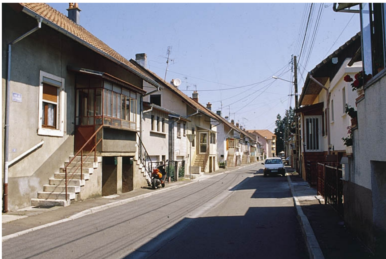
Logements ouvriers doubles rue du Commandant Prince.
