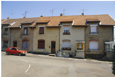
Logements ouvriers contigus. Phot. Yves Sancey IVR43_20009000589ZA
