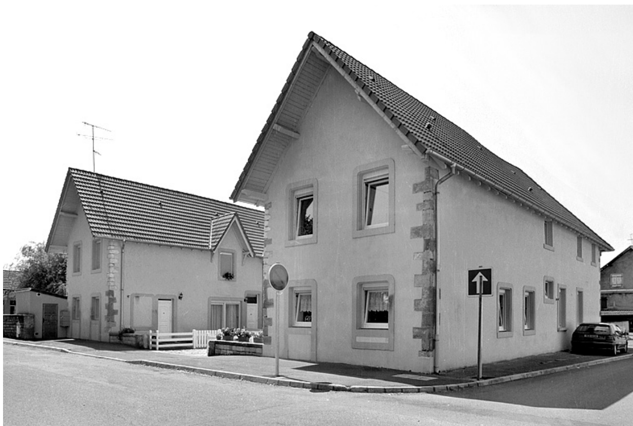
Logements ouvriers en U sur l'avenue des Forges.
