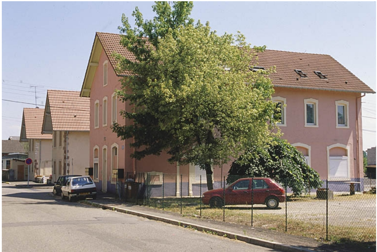
Logements ouvriers depuis l'avenue des Forges.
