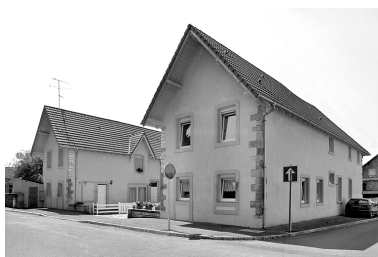
Logements ouvriers en U sur l'avenue des Forges. Phot. Yves Sancey IVR43_20009000578X
