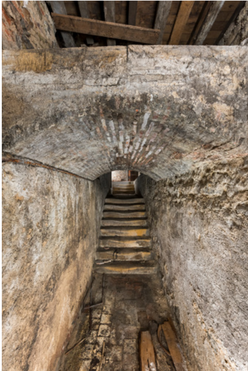
Couloir et escalier sous la salle.
