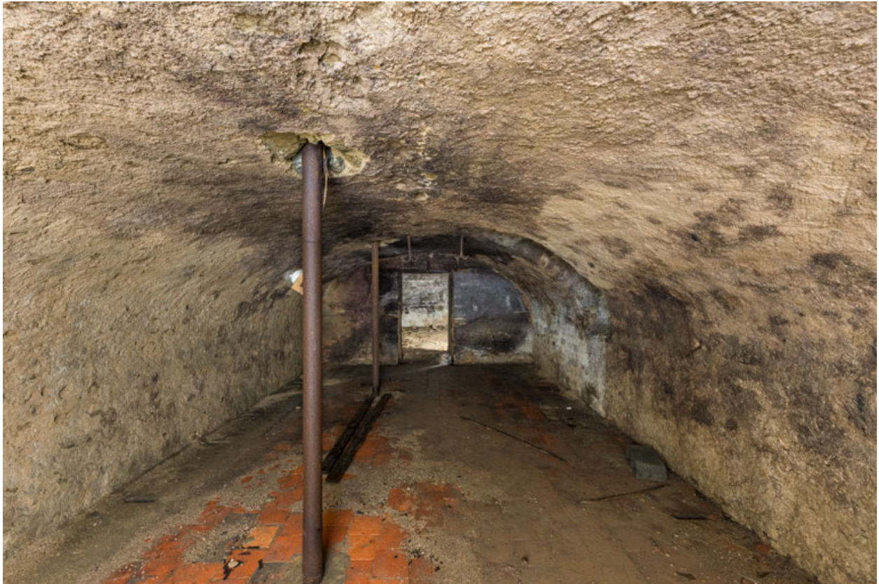
Cave voûtée sous la salle.
