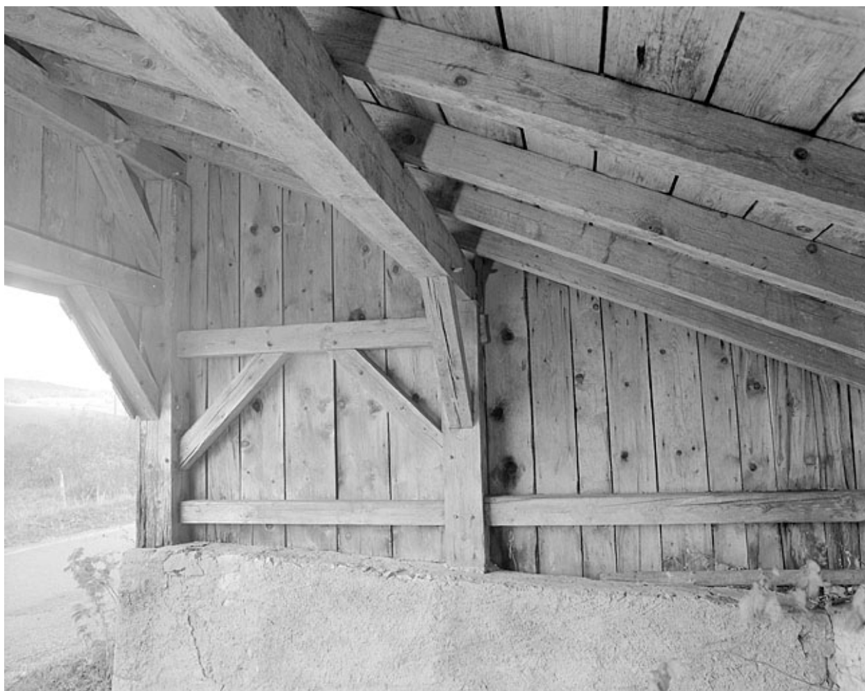
Détail de la charpente.
