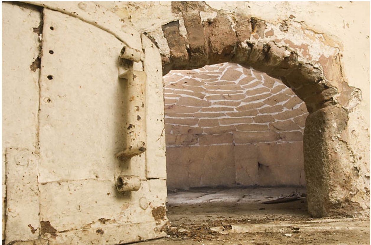
Cuisine du 1er étage : intérieur du four à pain.
