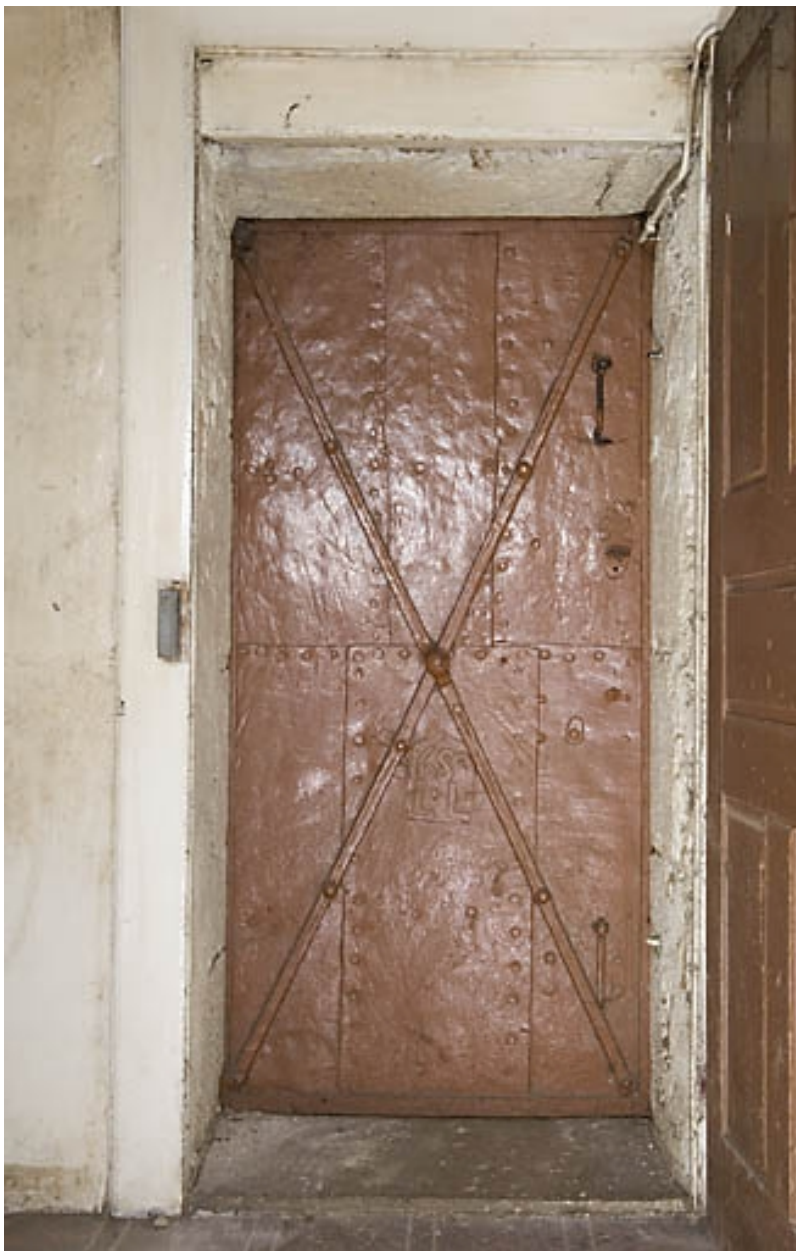
Appartement du 2nd étage : porte coupe-feu.
