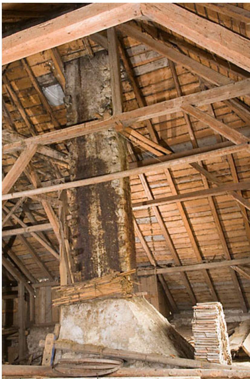
Grange : conduit de cheminée.
