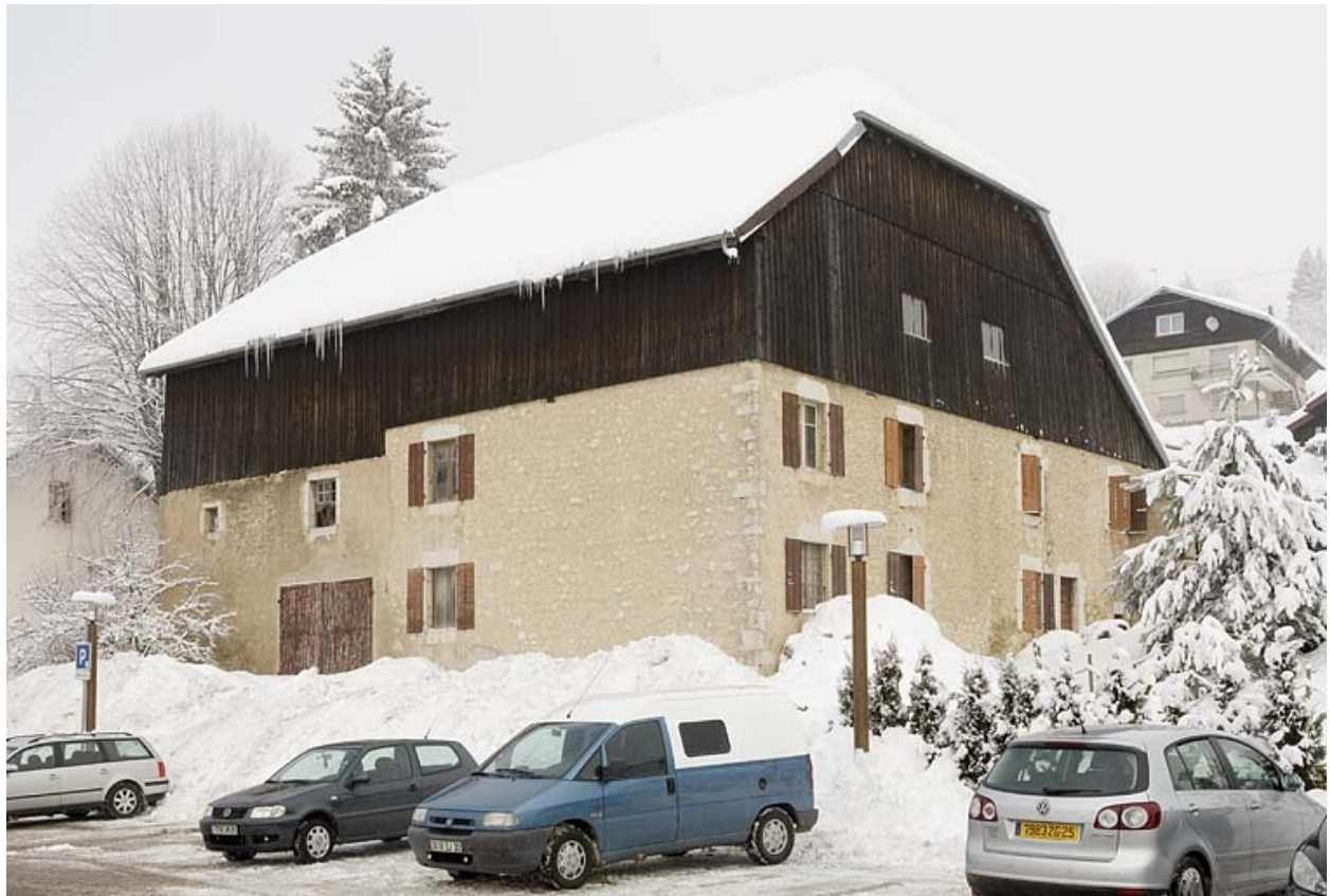
Façades postérieure et latérale gauche, en hiver.
