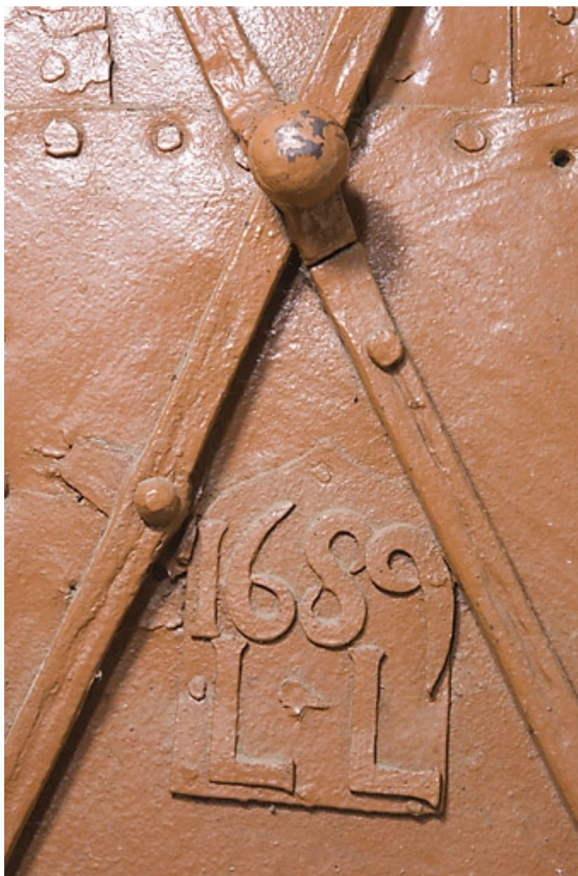
Appartement du 2nd étage : date 1689 et initiales LL sur la porte coupe-feu.
