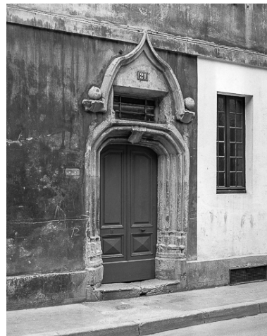
Détail : porte d'entrée sur la rue Gambetta, de trois quarts gauche. Phot. Yves Sancey IVR43_19802500276X
