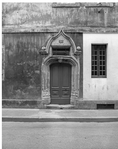
Détail : porte d'entrée sur la rue Gambetta, vue de face. Phot. Yves Sancey IVR43_19802500277X
