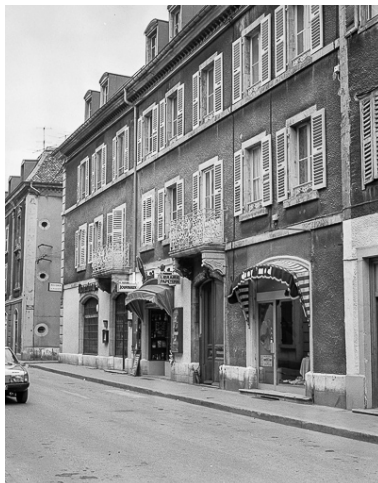
Façade sur la rue de la Gare. Phot. Yves Sancey IVR43_19802500278X
