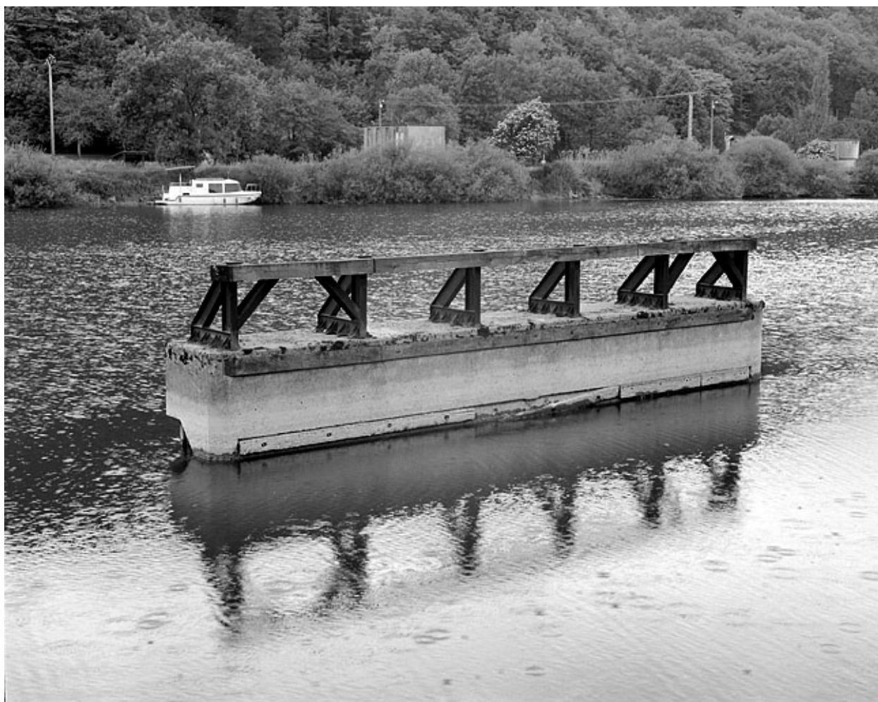
Un des éléments du mur guide.
