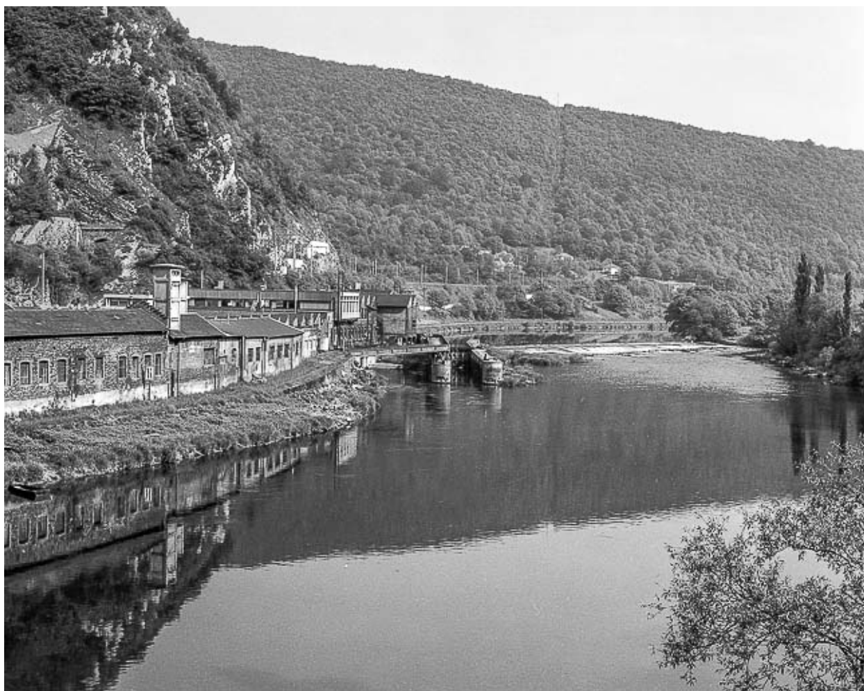
Vue d'ensemble depuis le pont en 1976.
