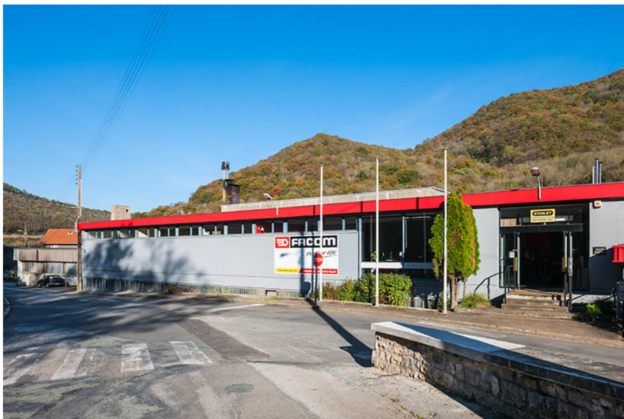
Entrée des bureaux.
