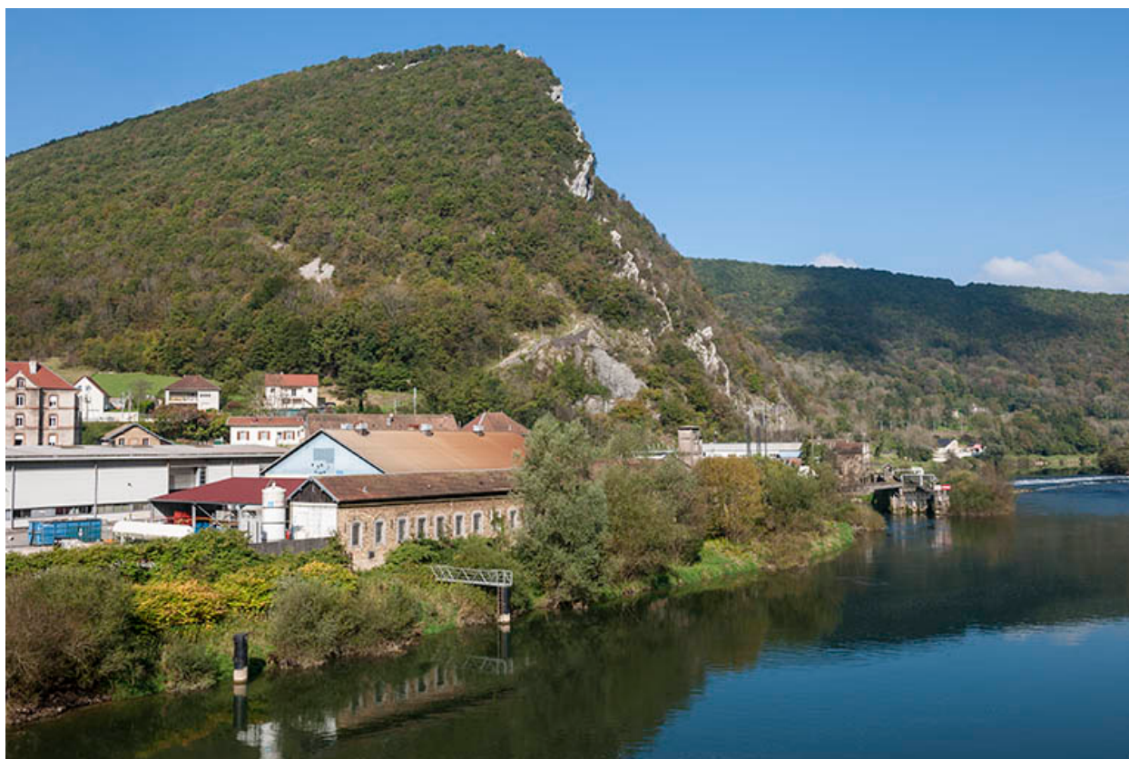
Vue d'ensemble depuis le pont en 2014.
