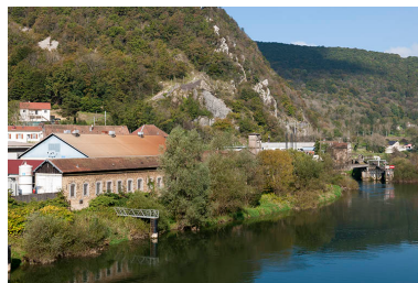
Vue rapprochée depuis le pont. Phot. Jérôme Mongreville IVR43_20142501603NUC4A
