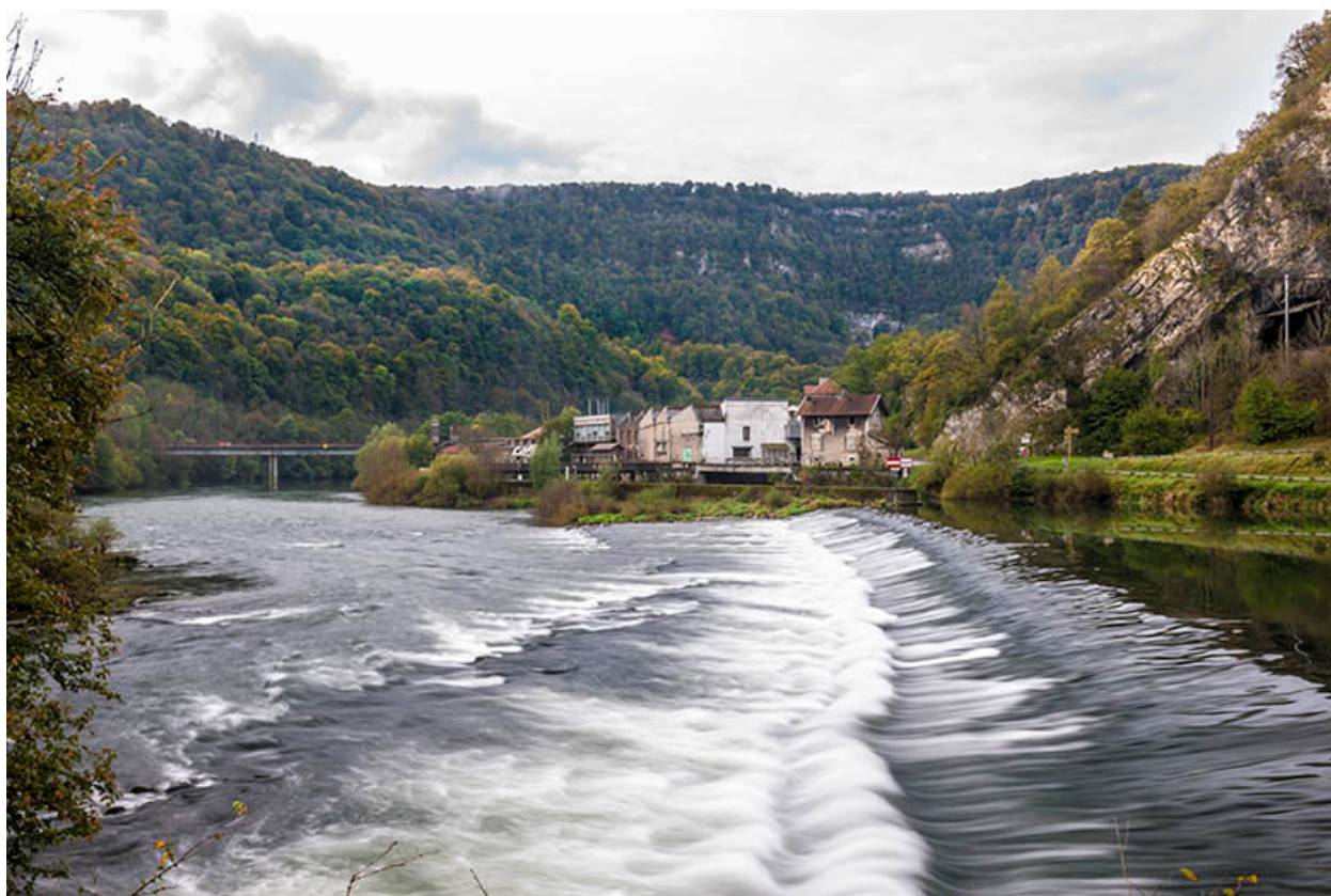
Vue d'ensemble depuis l'extrémité orientale du barrage.
