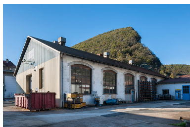
Atelier de forge, depuis la cour. Phot. Jérôme Mongreville IVR43_20142501614NUC4A
