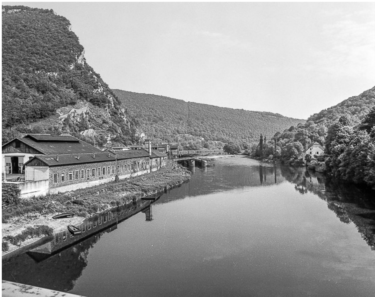
Vue d'ensemble depuis le pont en 1976.
