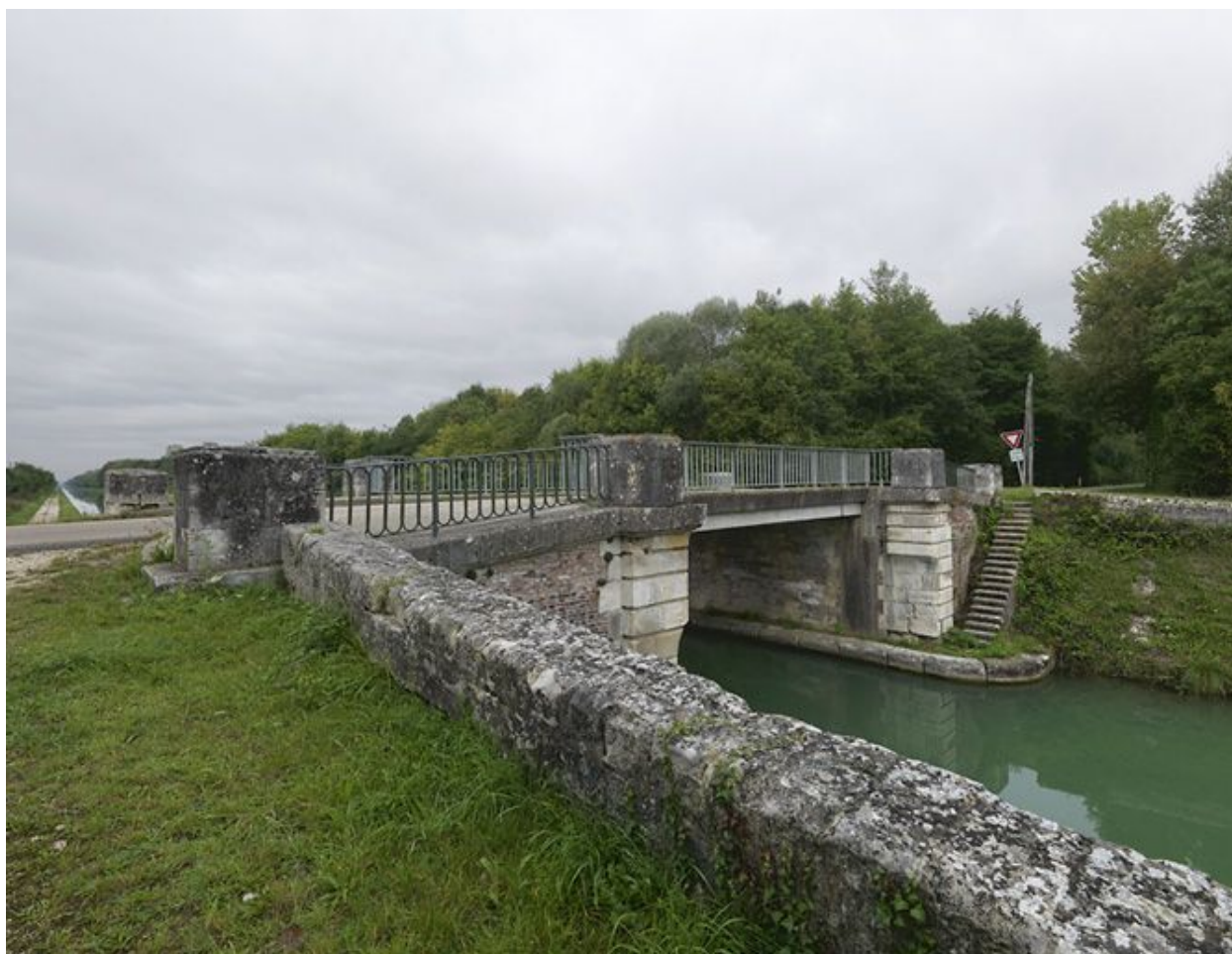
Vue de 3/4, remarquez l'escalier d'accès.
