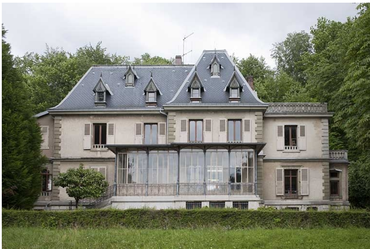
Façade antérieure depuis l'ouest.
