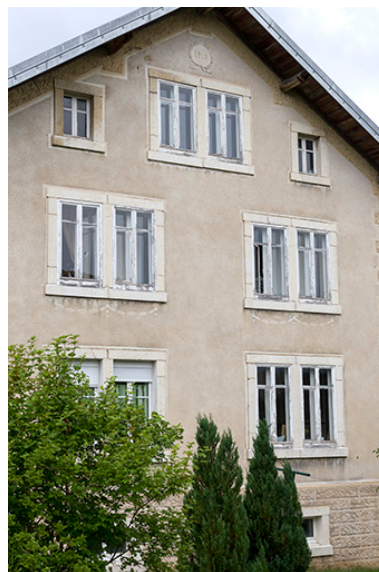
Façade latérale droite, de trois quarts gauche.
