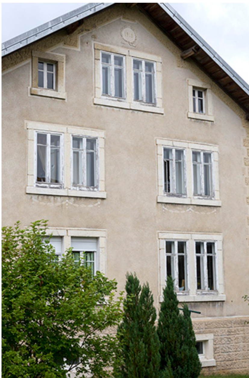
Façade latérale droite, de trois quarts gauche.
