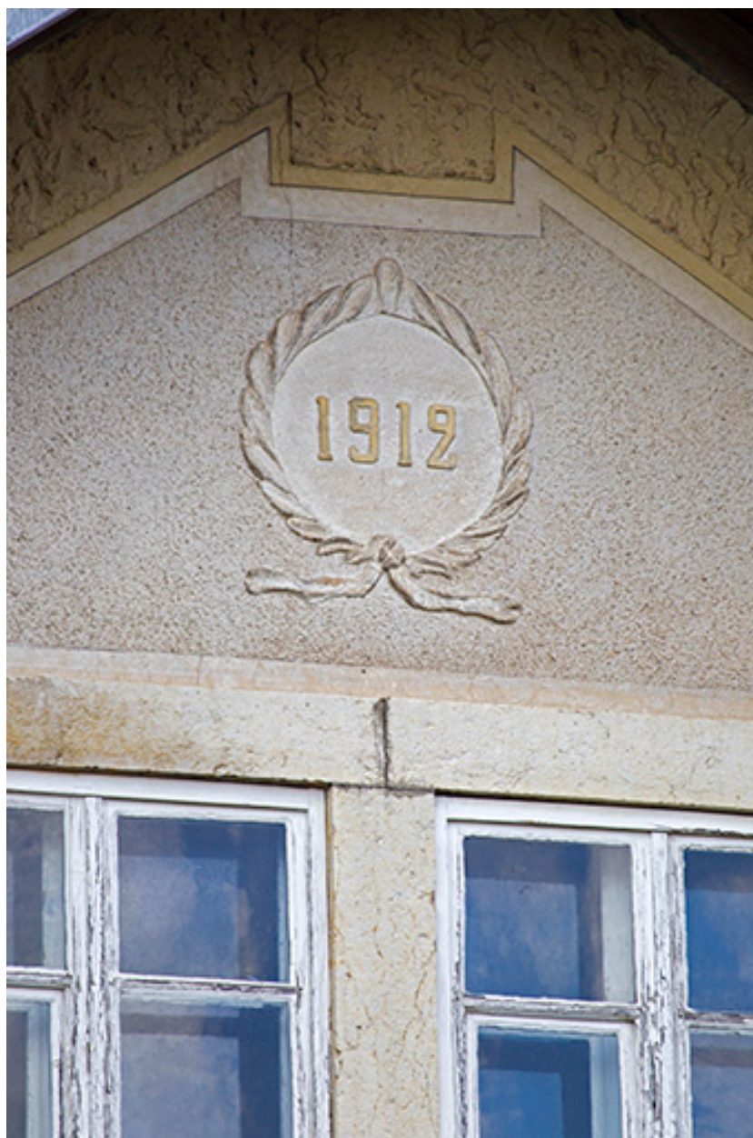
Façade latérale droite : date sur le pignon.
