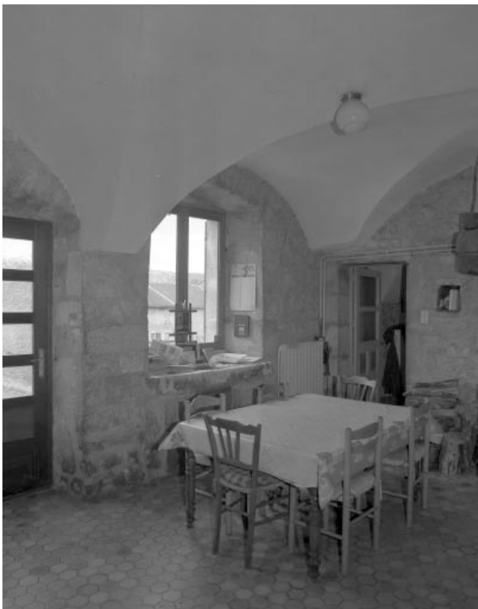
Intérieur du rez-de-chaussée : voûte d'arêtes.
