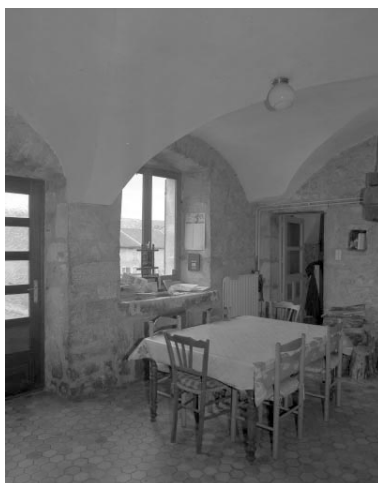
Intérieur du rez-de-chaussée : voûte d'arêtes. Phot. Jérôme Mongreville IVR43_19943900888X
