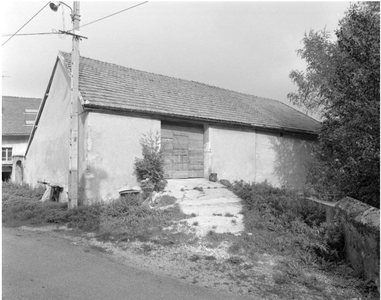
Partie agricole, accès à la grange.
