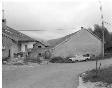
Vue générale de l'accès à la maison. Phot. Jérôme Mongreville IVR43_19943901137X
