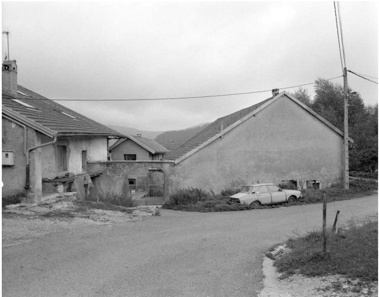
Vue générale de l'accès à la maison.
