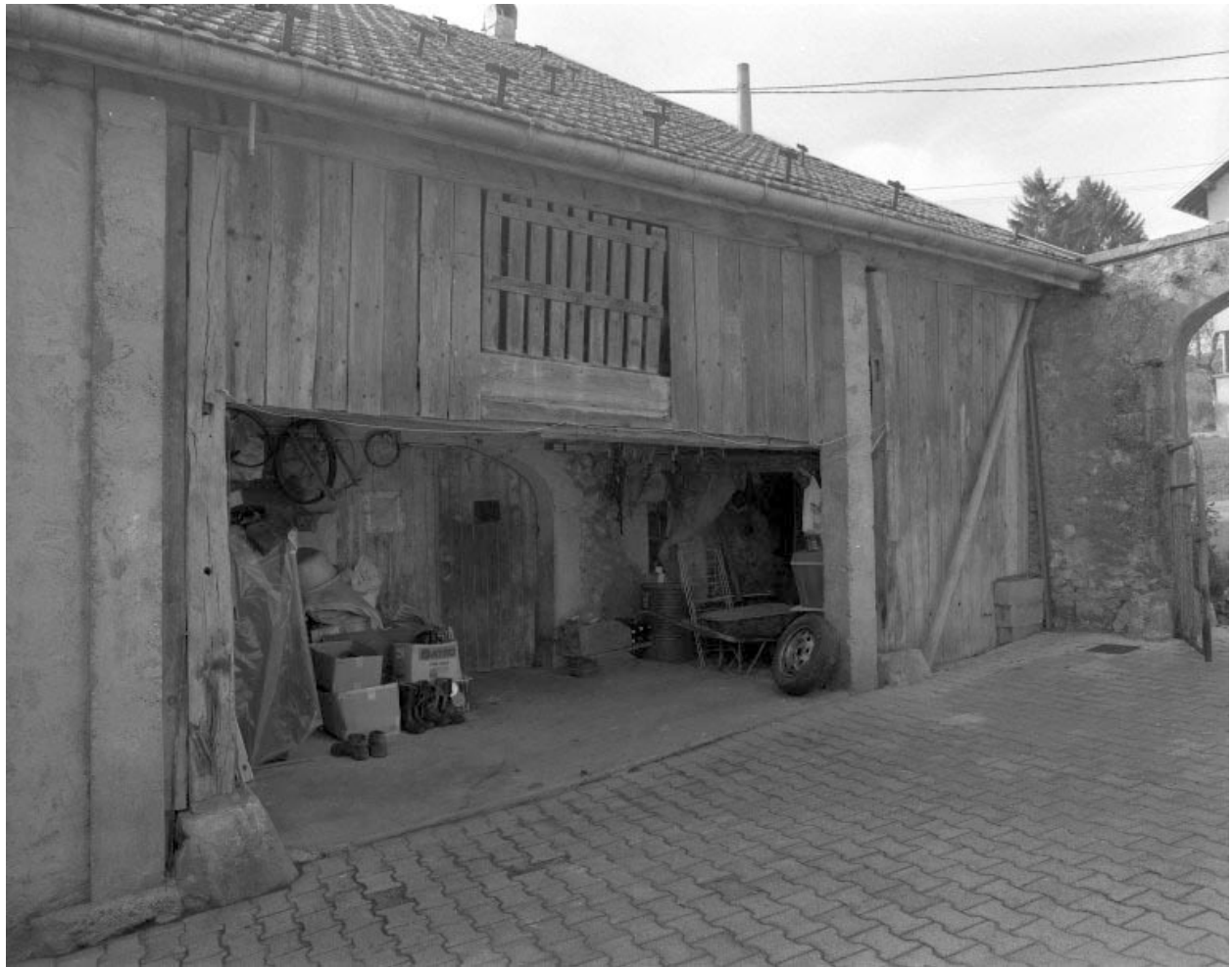
Accès à l'étable depuis la cour.
