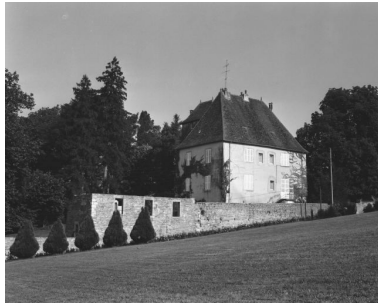
Demeure située route de Récanoz. Phot. Dominique Dominguez IVR43_19803900103X
