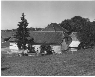
Relais de poste située au lieudit Mauffans. Phot. Yves Sancey IVR43_19803900115X
