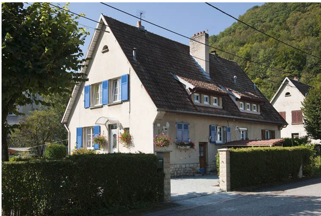
Maison jumelée. Pignon et façade nord.
