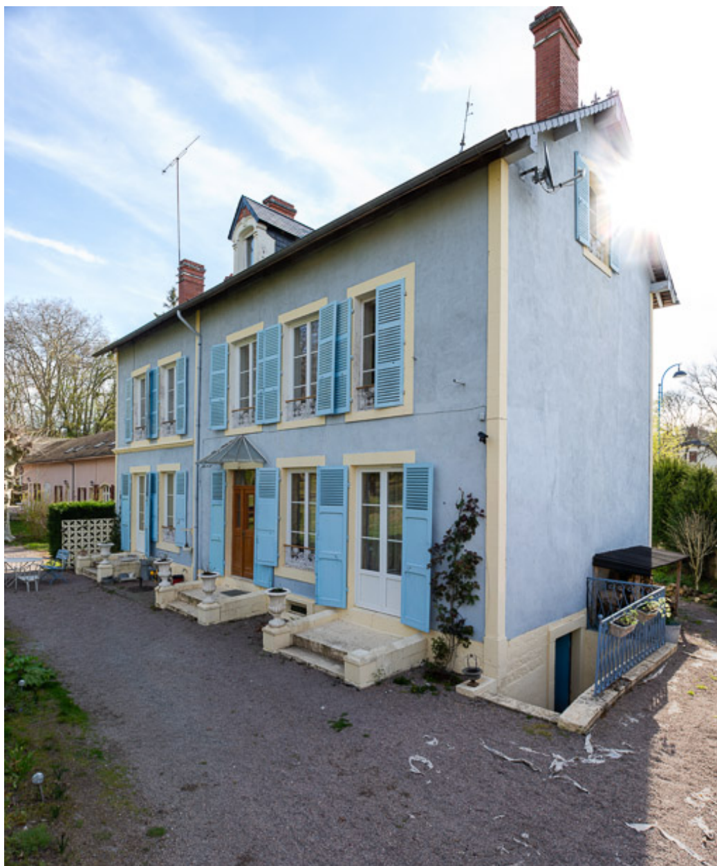
Façade nord-ouest et pignon sud-ouest.
