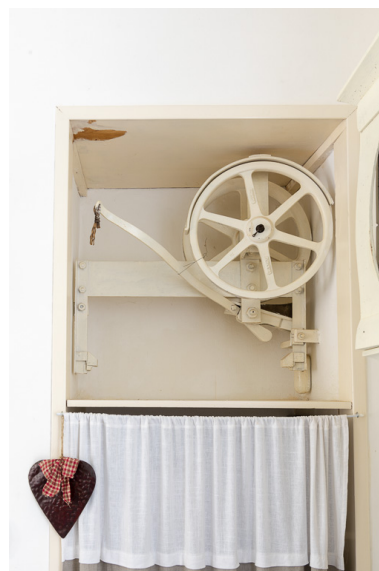
Mécanisme de monte-charge. Phot. Pierre-Marie Barbe-Richaud IVR26_20195800070NUC4A
