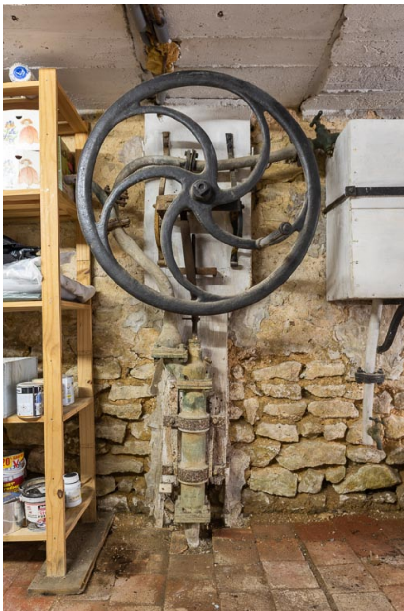
Pompe à manivelle de la cave.
