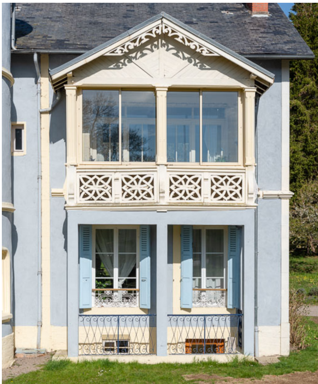
Façade sud-est, oriel.
