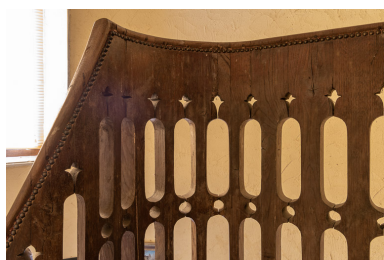
Escalier en vis, rampe d'appui. Phot. Pierre-Marie Barbe-Richaud IVR26_20195800072NUC4A
