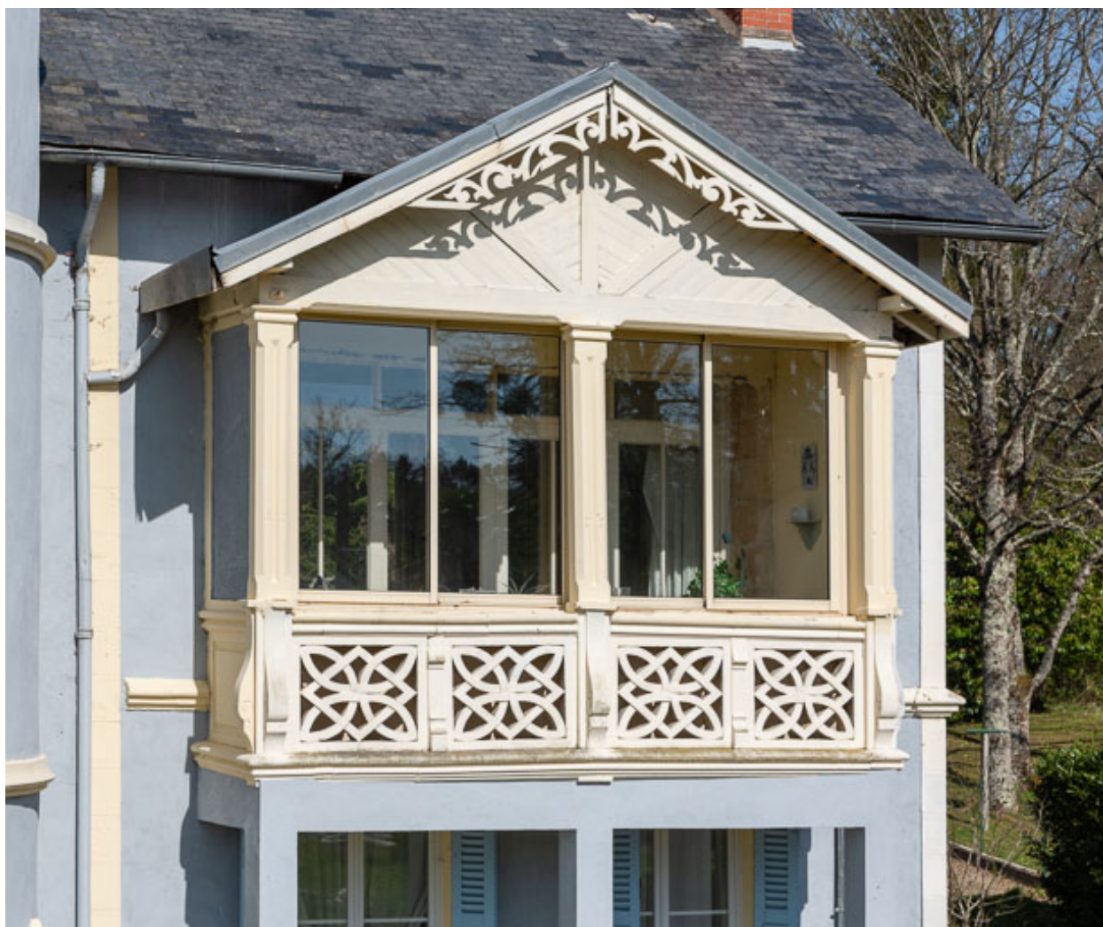
Façade sud-est, oriel.
