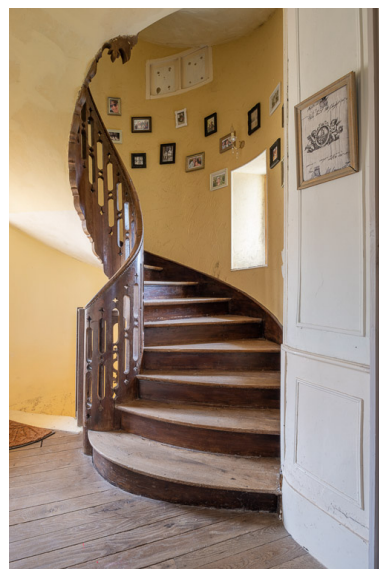
Escalier en vis. Phot. Pierre-Marie Barbe-Richaud IVR26_20195800053NUC4AQ
