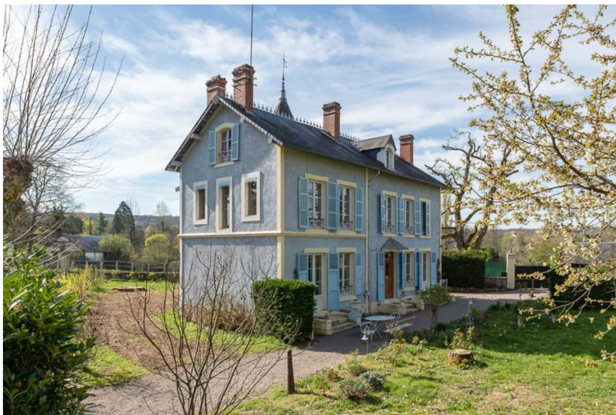
Façade nord-ouest et mur pignon nord-est.
