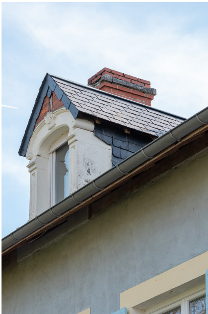
Lucarne de la façade nord-ouest.
