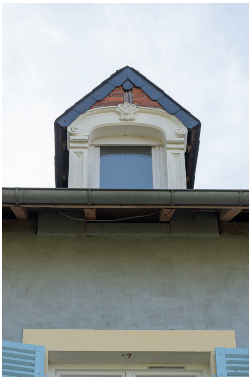
Lucarne de la façade nord-ouest.
