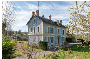
Façade nord-ouest et mur pignon nord-est. Phot. Pierre-Marie Barbe-Richaud IVR26_20195800061NUC4A
