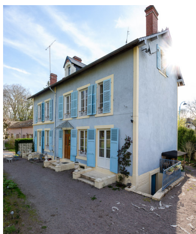
Façade nord-ouest et pignon sud-ouest. Phot. Pierre-Marie Barbe-Richaud IVR26_20195800058NUC4AQ
