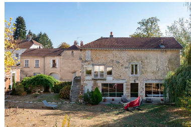
L'ancien bâtiment à usage de tannerie. Phot. Jérôme Mongreville IVR43_20187000705NUC4A
