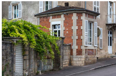
Le pavillon en brique, détail. Phot. Jérôme Mongreville IVR43_20187000280NUC4A
