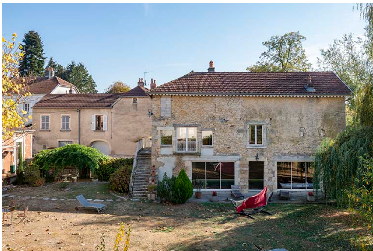
L'ancien bâtiment à usage de tannerie.
