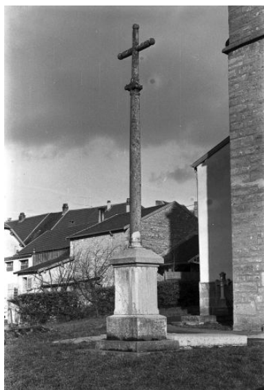
Vue générale. Phot. Guy Forestier IVR43_19743900536Z
