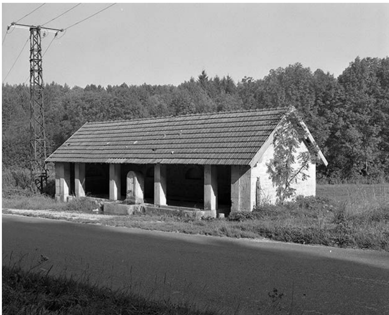
Fontaine-lavoir située rue de l'Eglise.
