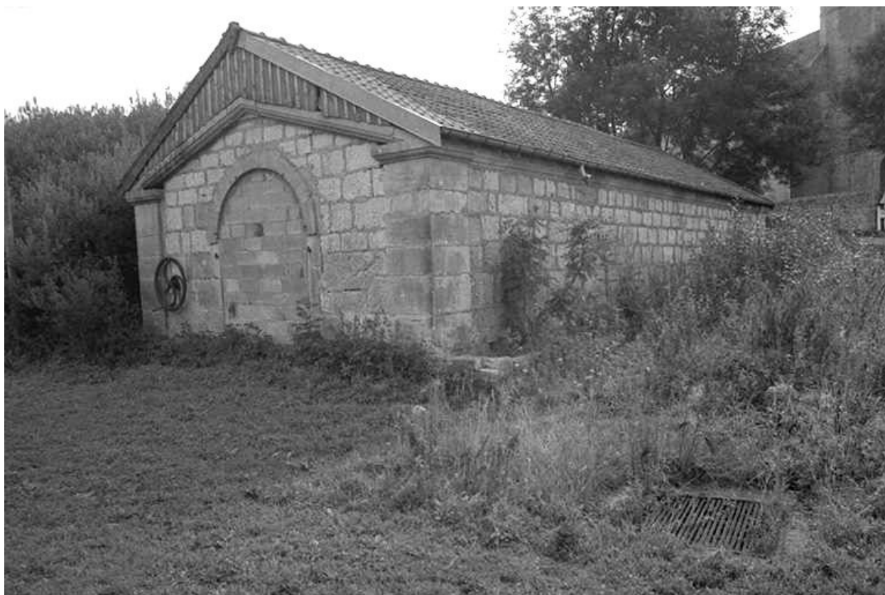
Fontaine, abreuvoir cadastrée 1972 AB 15 : vue générale.
