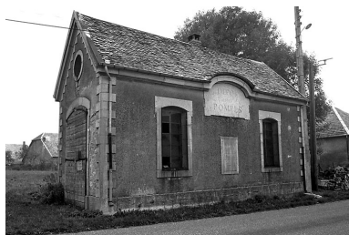
Entrepôt public situé rue du Château. Phot. Gilbert Poinot IVR43_19762500837Z
