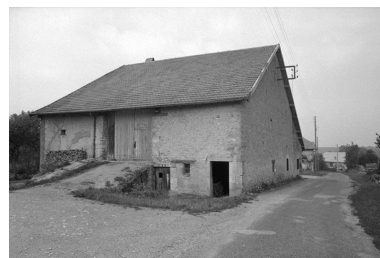
Ferme située rue de l'Abreuvoir. Phot. Gilbert Poinot IVR43_19762500835Z
