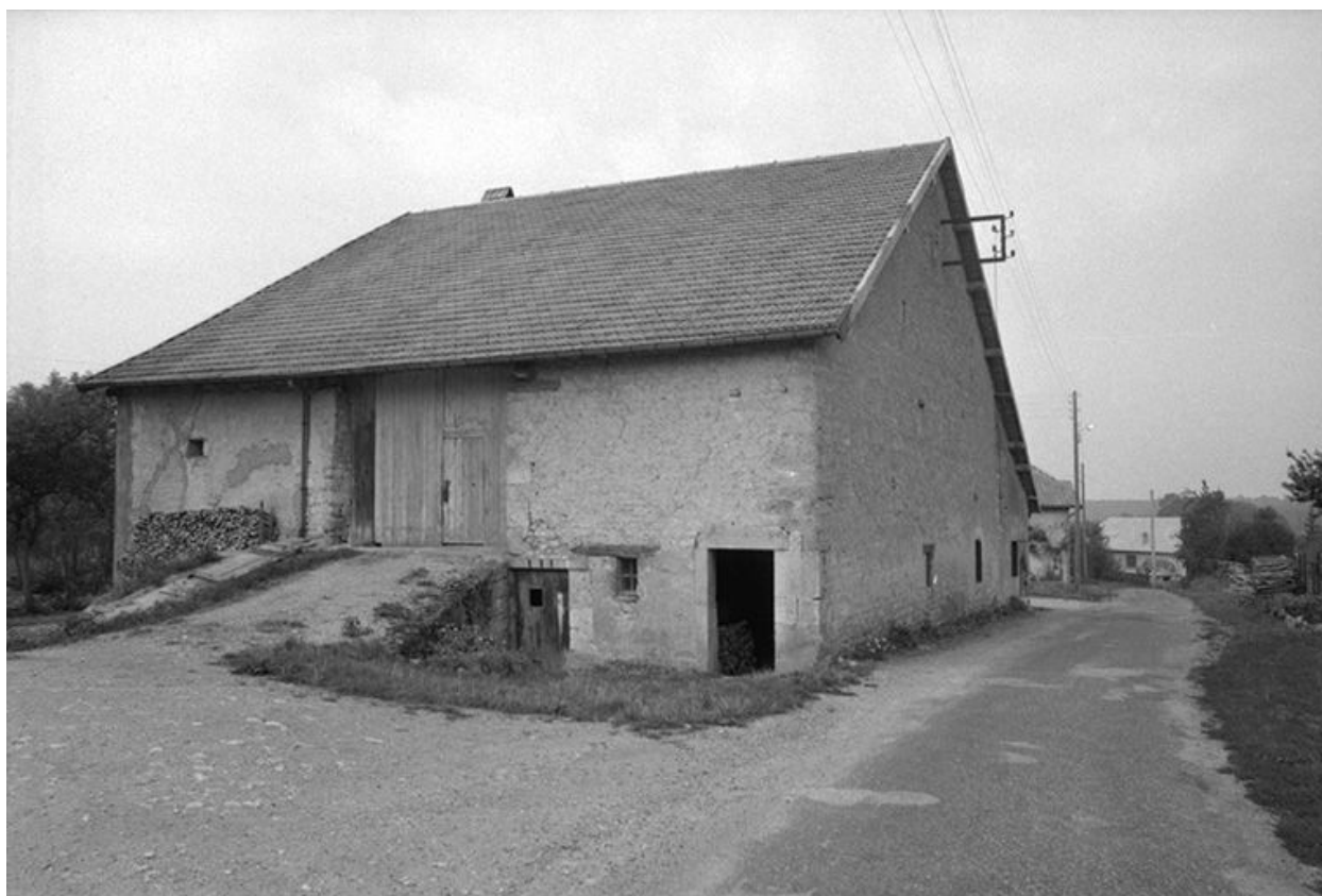
Ferme située rue de l'Abreuvoir.
