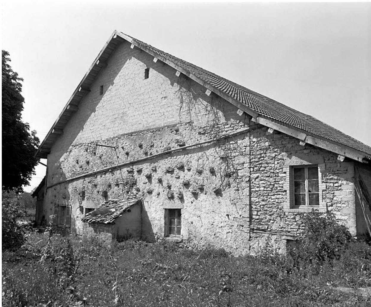
Ferme située rue du Chalet.
