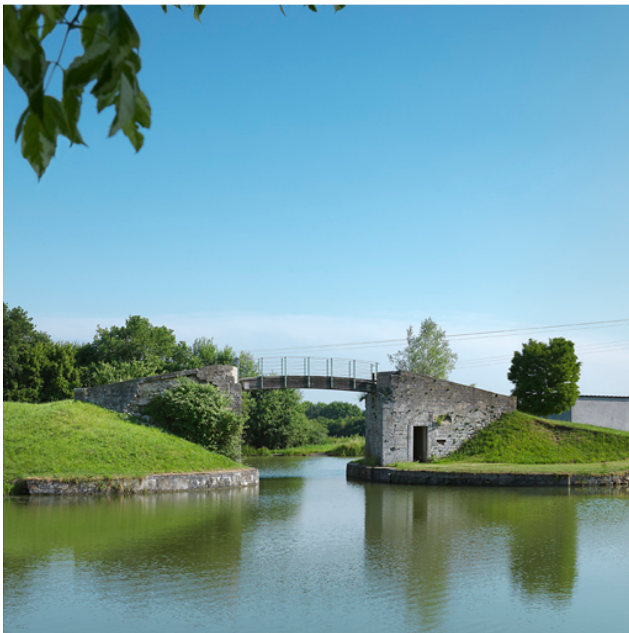
Vue de la passerelle haute, de face.
