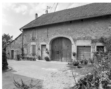
Ferme située rue du Grand Four. Phot. Yves Sancey IVR43_19843900318X
