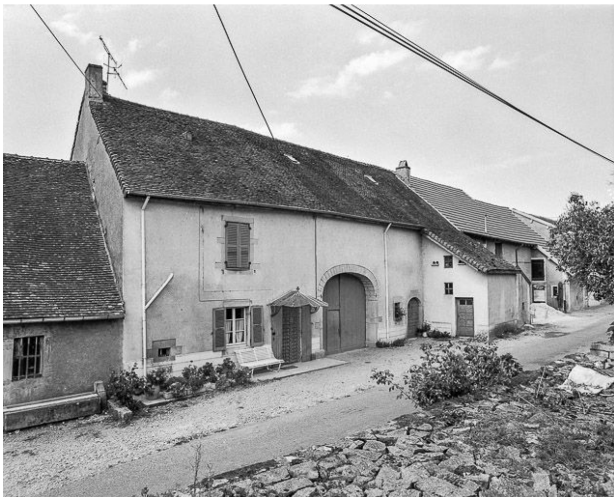
Maisons et fermes situées route Principale.
