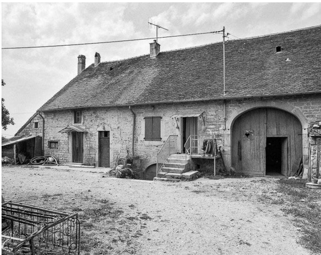
Ferme située route de Sainte-Agnès.
