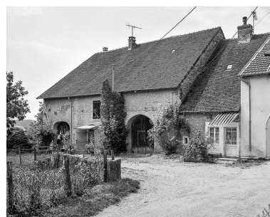
Ferme située rue du Petit Four. Phot. Yves Sancey IVR43_19843900317X
