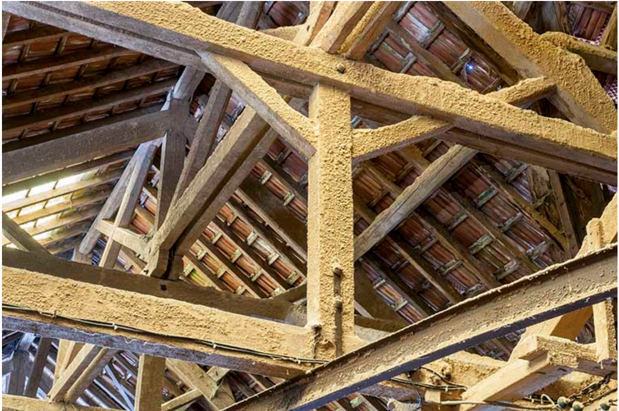
Détail de la charpente de l'atelier.
