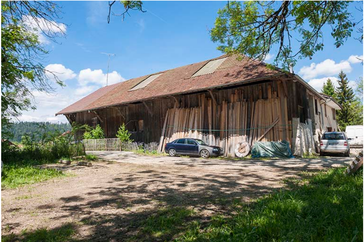
Atelier de scierie vu depuis le sud-est.
