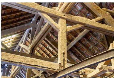
Détail de la charpente de l'atelier. Phot. Jérôme Mongreville IVR43_20162500437NUC4A
