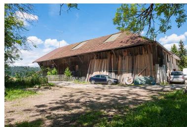
Atelier de scierie vu depuis le sud-est. Phot. Jérôme Mongreville IVR43_20162500424NUC4A
