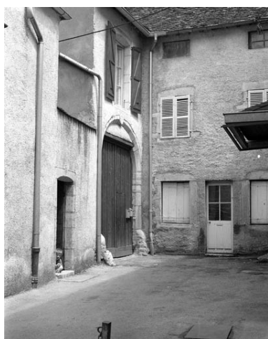
Façade latérale droite : la porte cochère. Phot. Yves Sancey IVR43_19897000210X
