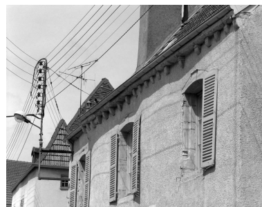
Détail : corniche de la façade antérieure. Phot. Yves Sancey IVR43_19897000211X
