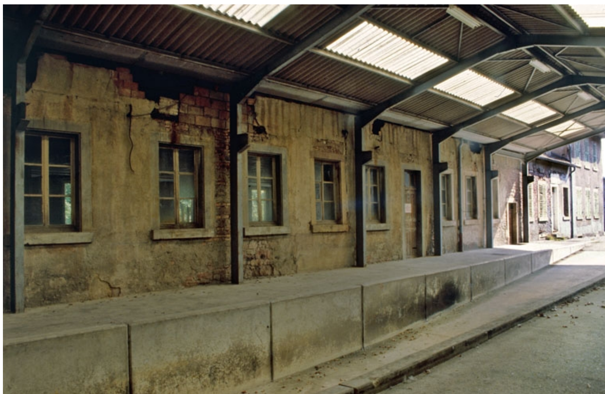
Quai couvert établi contre l'ancien tissage.
