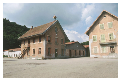
Bâtiments du tissage depuis le sud-est.
