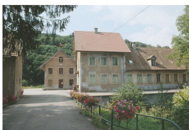
Vue d'ensemble depuis l'entrée. Phot. Yves Sancey IVR43_19999000002ZA
