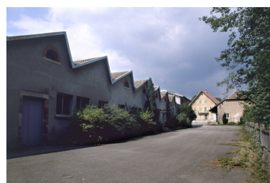
Sheds de l'atelier de filature.
