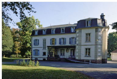
Logement patronal depuis le nord. Phot. Yves Sancey IVR43_19999000023ZA
