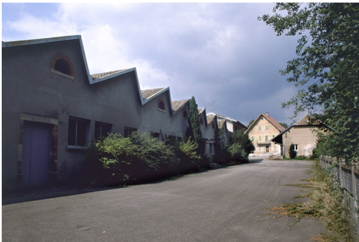
Sheds de l'atelier de filature.
