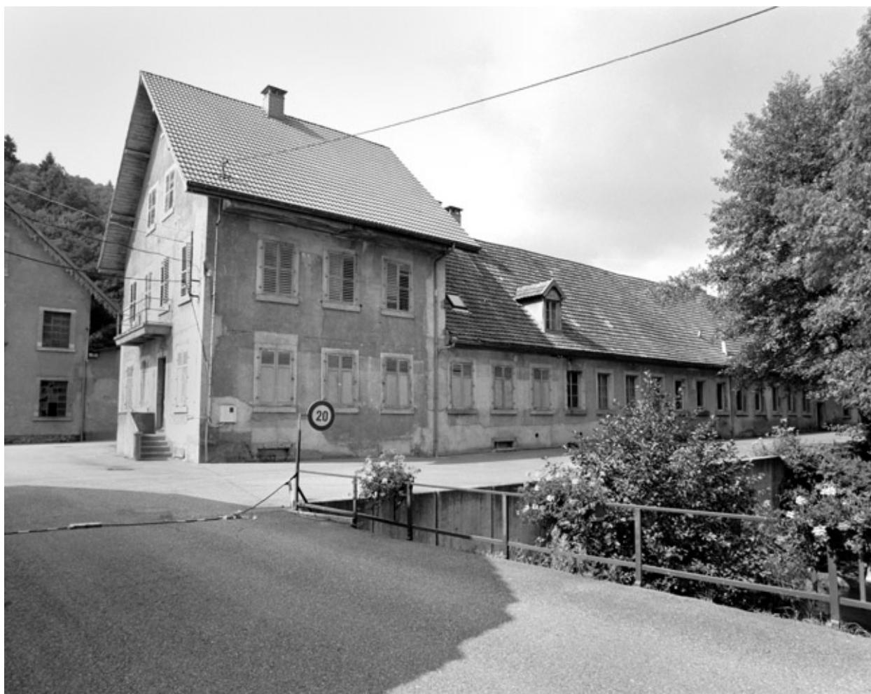
Bureaux et conciergerie depuis l'entrée.
