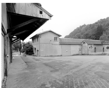
Bâtiments de la filature depuis le nord.
