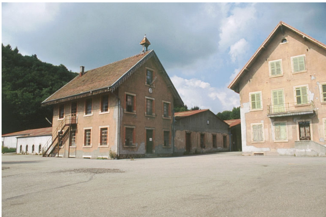
Bâtiments du tissage depuis le sud-est.
