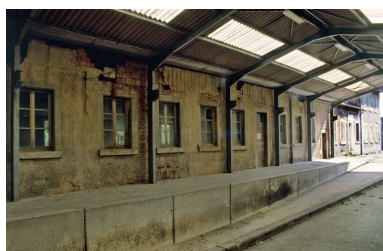
Quai couvert établi contre l'ancien tissage.
