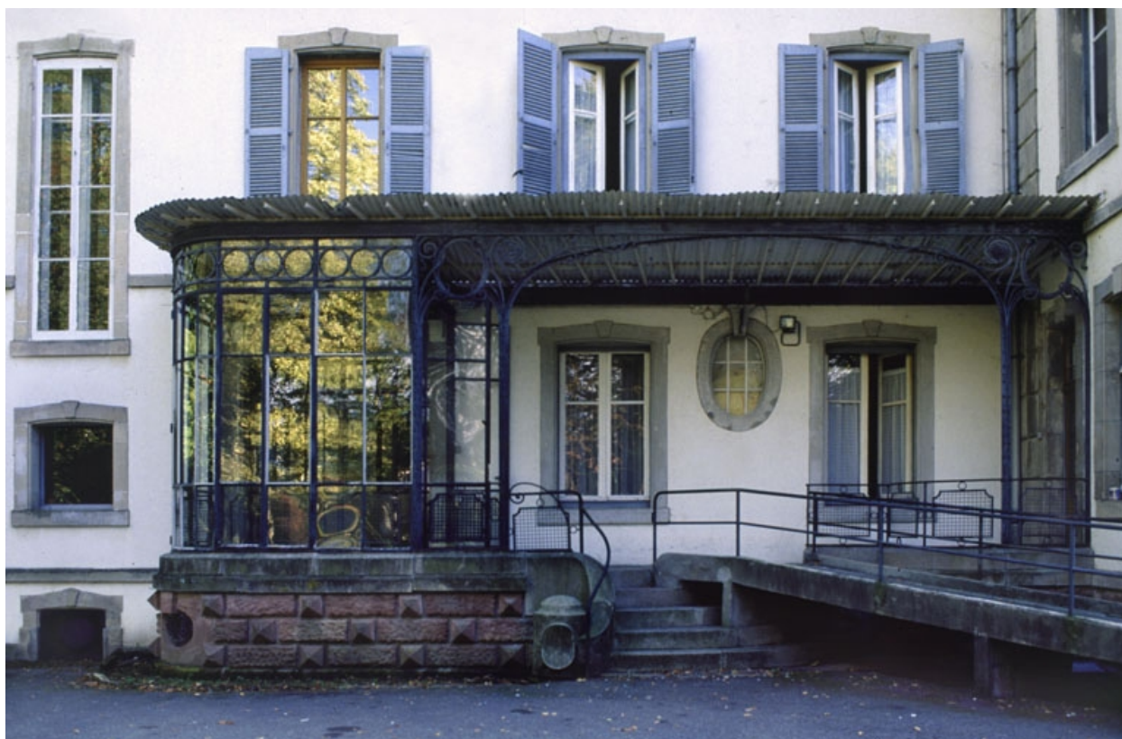
Perron et véranda du logement patronal.
