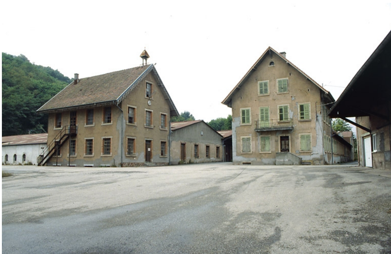
Laboratoire, bureaux et conciergerie depuis le sud.
