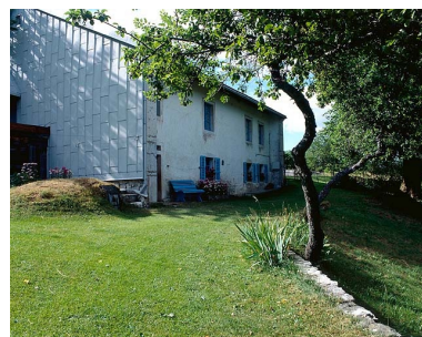
Ferme située au lieu-dit Sur-les-Couronnes. Phot. Jérôme Mongreville IVR43_19943900715XA
