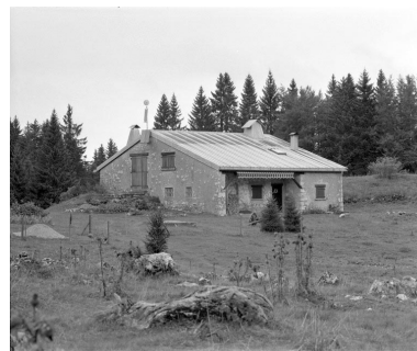
Ferme située au lieu-dit au Montechoux Phot. Yves Sancey IVR43_19943901040X
