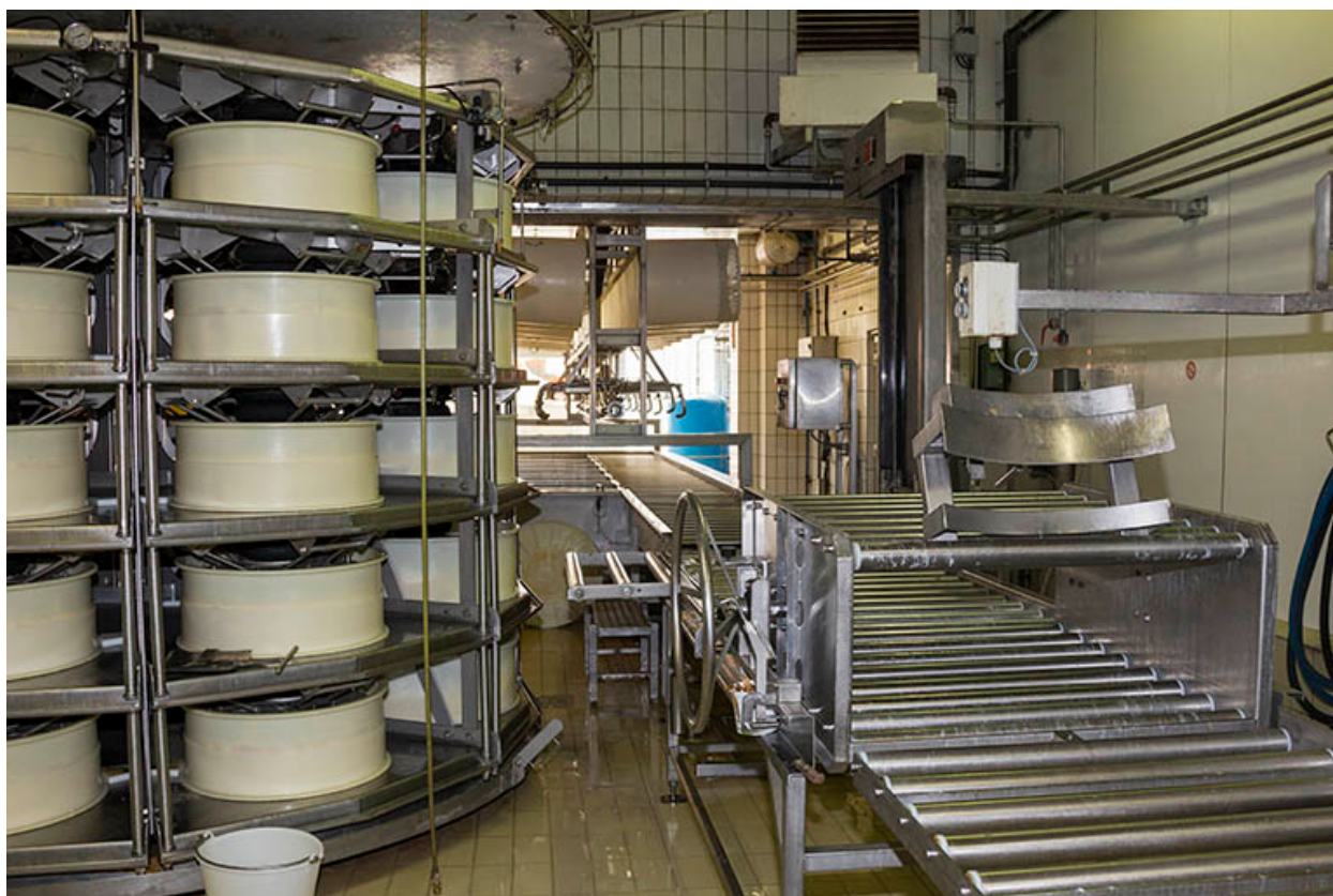
Installation de pressage et convoyeur.
