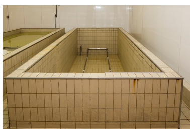
L'une des deux cuves à saumure. Phot. Yves Sancey IVR43_20132501465NUC2A
