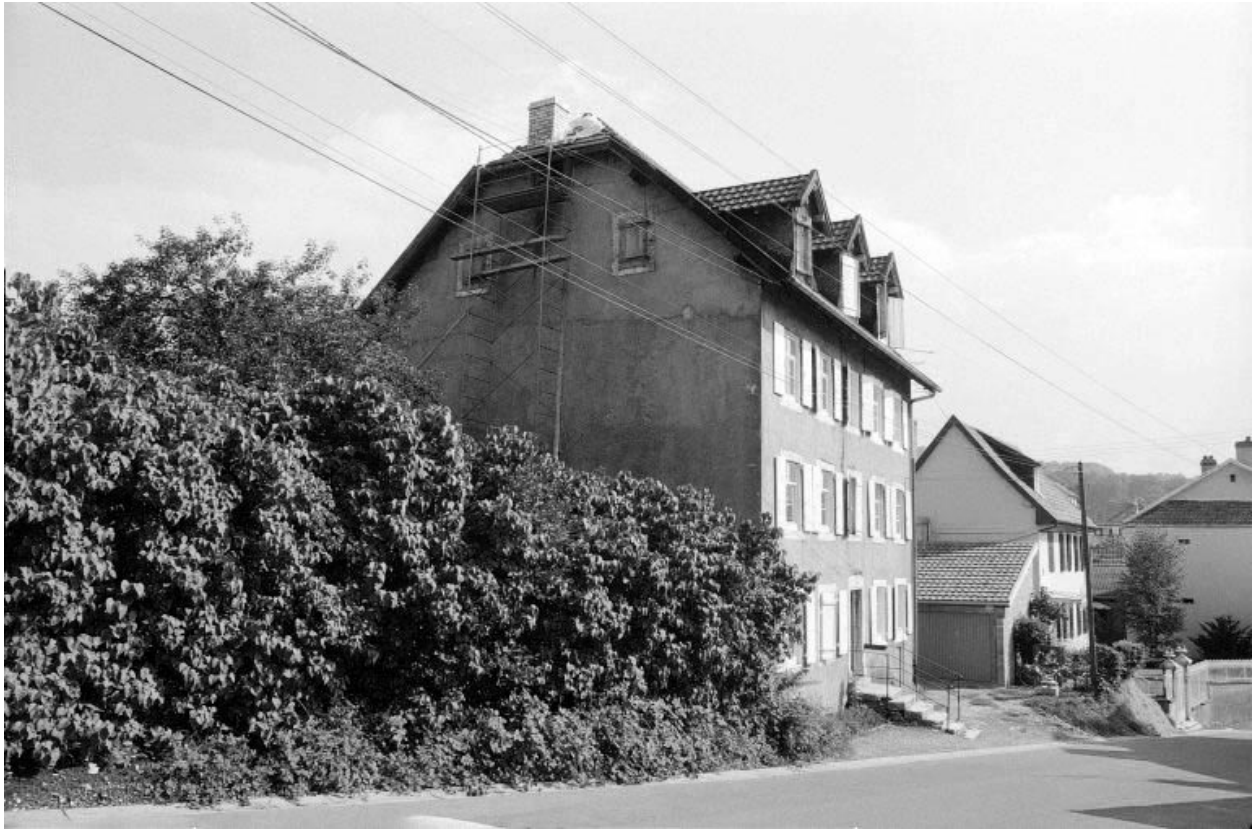
Façades antérieure et latérale gauche.
