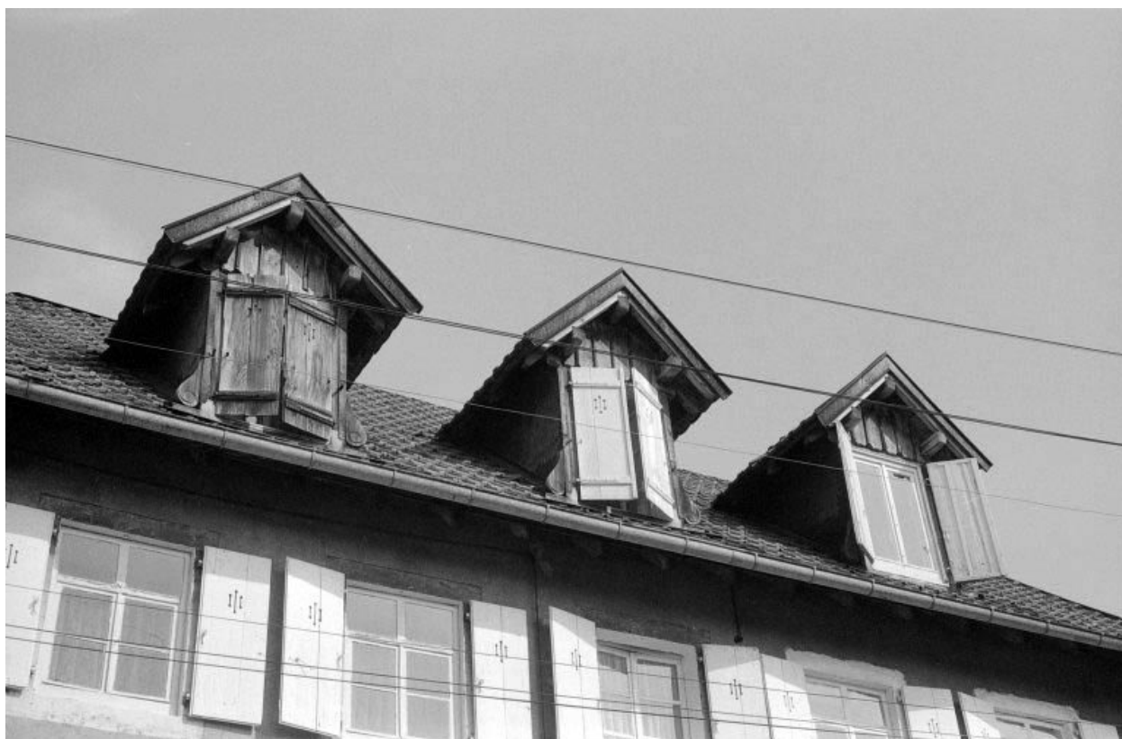
Façades antérieure : détail des lucarnes.
