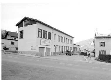
Vue d'ensemble depuis le sud : élévation antérieure. Phot. Yves Sancey IVR43_20033900444X
