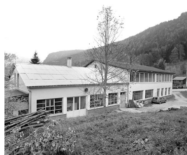
Vue d'ensemble depuis le nord : élévation postérieure. Phot. Yves Sancey IVR43_20033900445X
