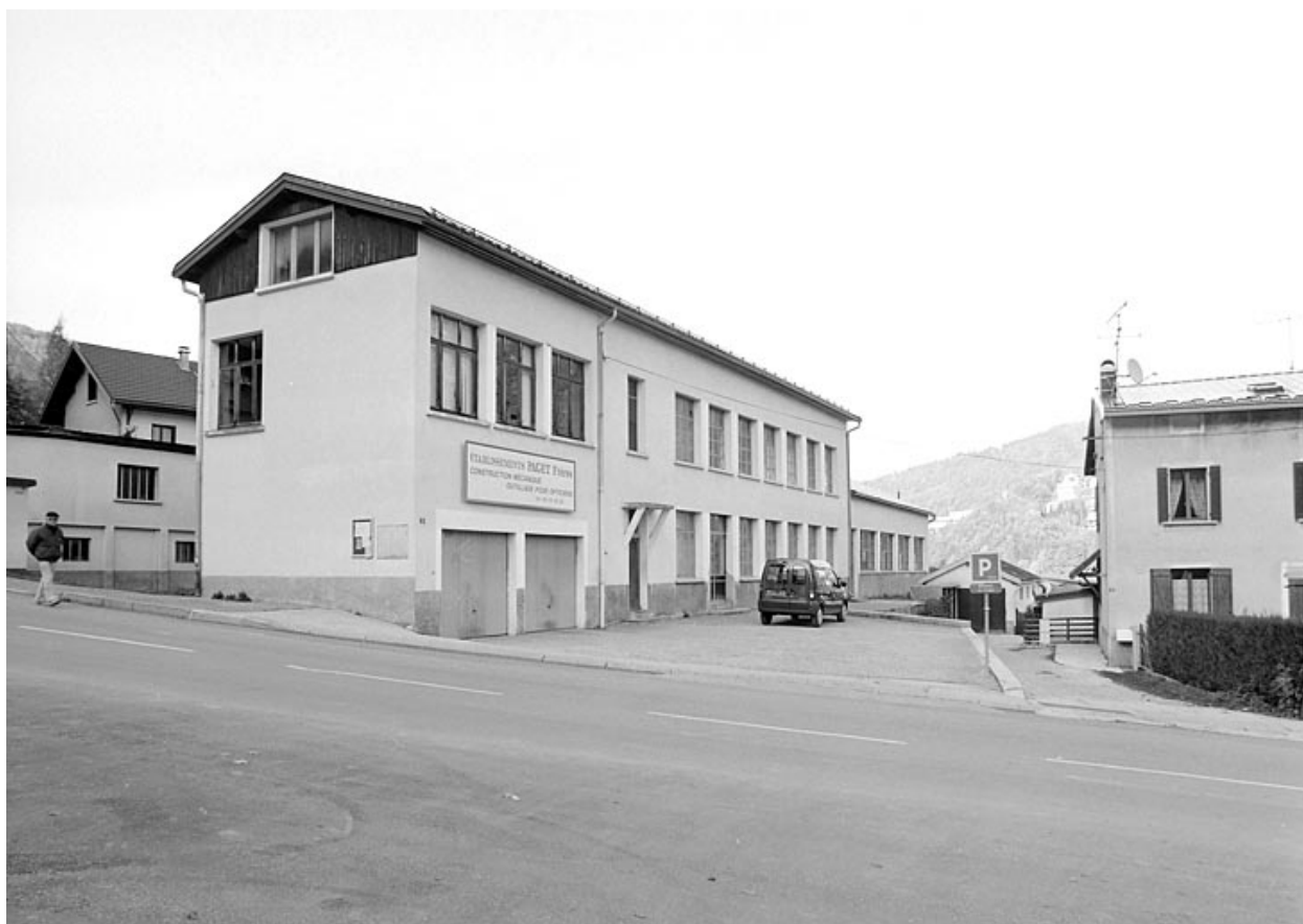
Vue d'ensemble depuis le sud : élévation antérieure.
