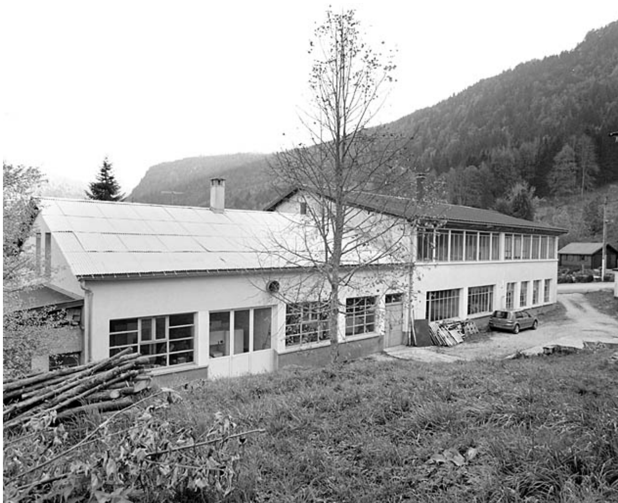
Vue d'ensemble depuis le nord : élévation postérieure.
