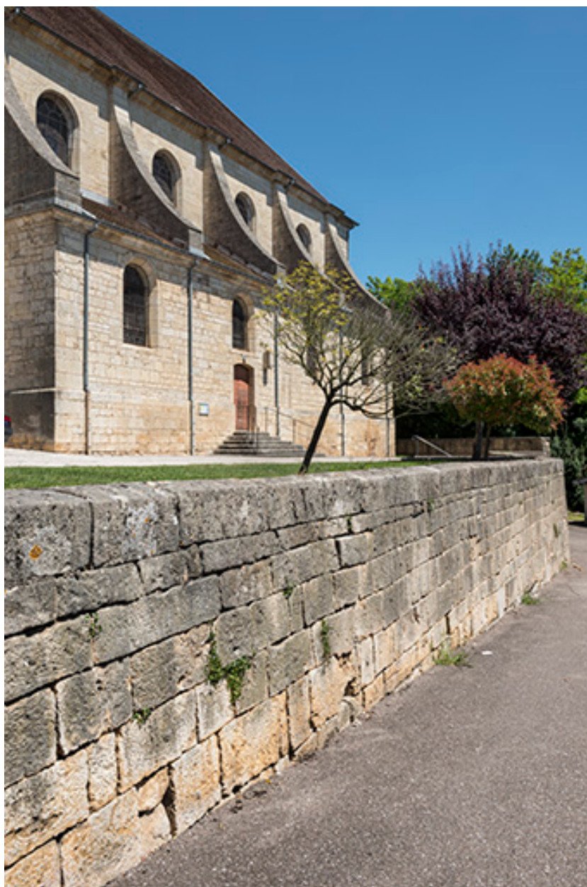
Flanc sud, mur de l'ancien cimetière.
