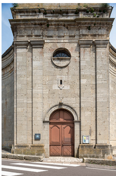
Clocher, premier niveau. Phot. Jérôme Mongreville IVR43_20187000546NUC4A
