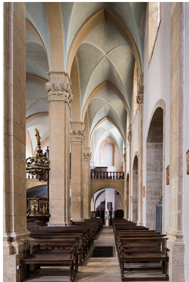
Bas-côté nord, vue en direction de la tribune. Phot. Jérôme Mongreville IVR43_20187000555NUC4A
