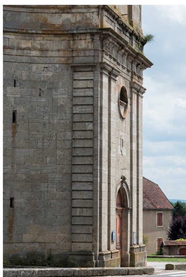
Clocher, premier niveau. Phot. Jérôme Mongreville IVR43_20187000542NUC4A
