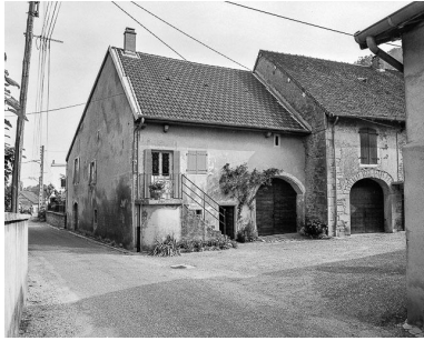
Façades antérieures et latérale gauche.
