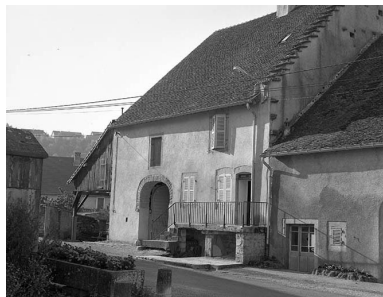
Façade antérieure vue de trois quarts. Phot. Dominique Dominguez IVR43_19803900234X
