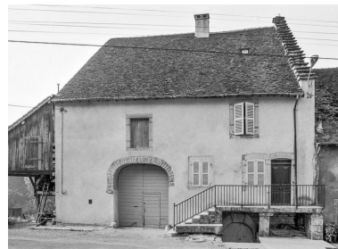
Façade antérieure. Phot. Bernard Pontefract IVR43_19763900300Z
