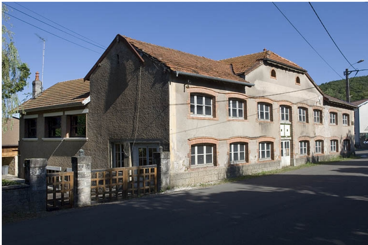
Vue d'ensemble depuis le sud.
