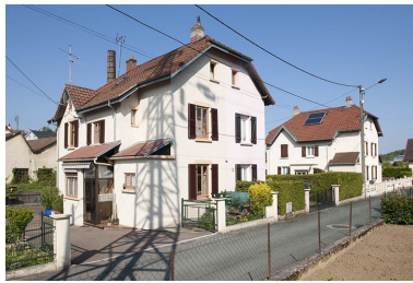
Maisons jumelées. Phot. Jérôme Mongreville IVR43_20112501390NUC4A
