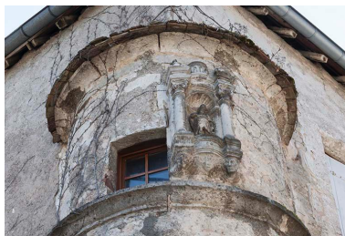
Détail du décor de l'échauguette Phot. Jérôme Mongreville IVR43_20137000357NUCA
