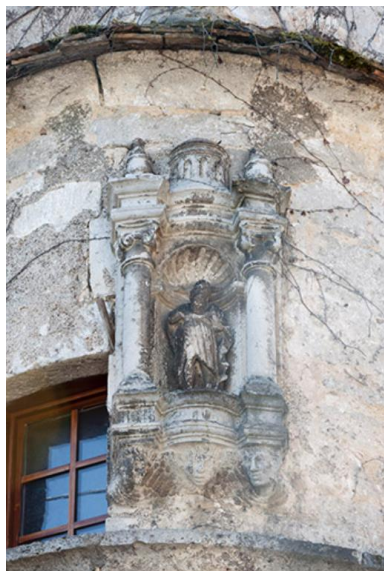
Détail du décor de l'échauguette Phot. Jérôme Mongreville IVR43_20137000356NUCA
