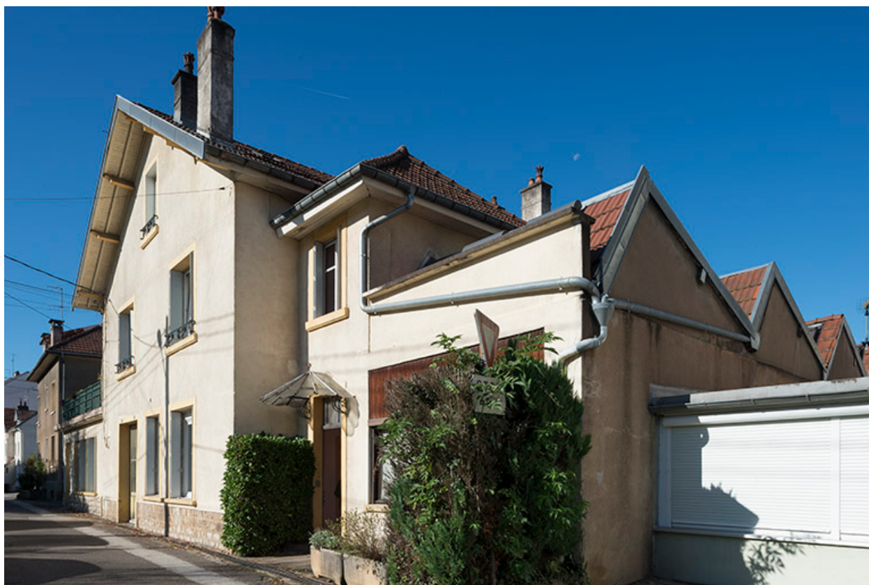
Logement et partie nord de l'atelier.
