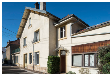
Façades sud vues de trois quarts droite. Phot. Jérôme Mongreville IVR43_20172501332NUC4A
