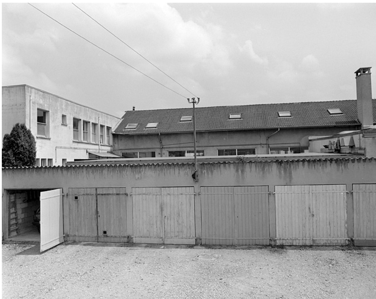
Bureau et atelier de fabrication depuis l'ouest.
