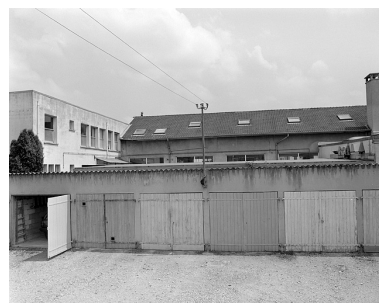
Bureau et atelier de fabrication depuis l'ouest. Phot. Jérôme Mongreville IVR43_19963900618X
