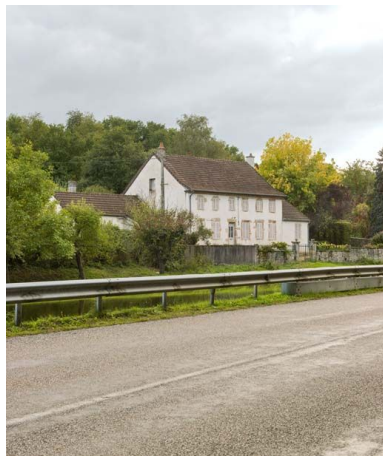
Vue d'ensemble de la demeure et du canal.
