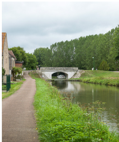
Vue d'ensemble du site et du pont. Phot. Pierre-Marie Barbe-Richaud IVR26_20175800391NUC2A
