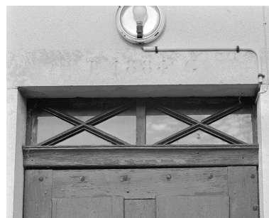
Date portée sur la façade antérieure. Phot. Jérôme Mongreville IVR43_19963901392X
