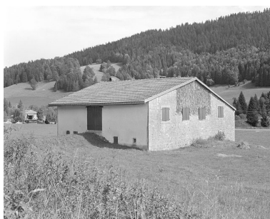
Façade postérieure et face sud-ouest. Phot. Jérôme Mongreville IVR43_19963901389X
