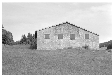
Face sud-ouest. Phot. Jérôme Mongreville IVR43_19963901387X
