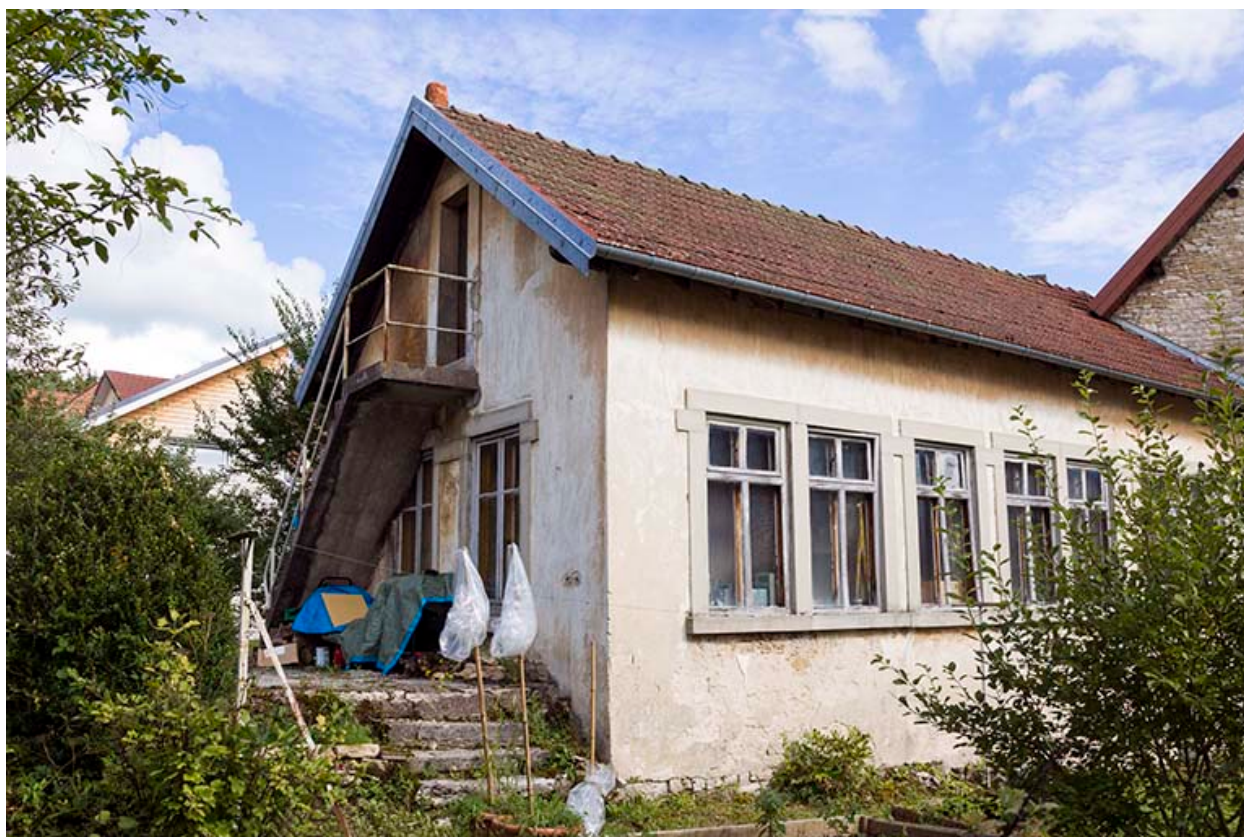
Usine : façades postérieure et latérale droite.
