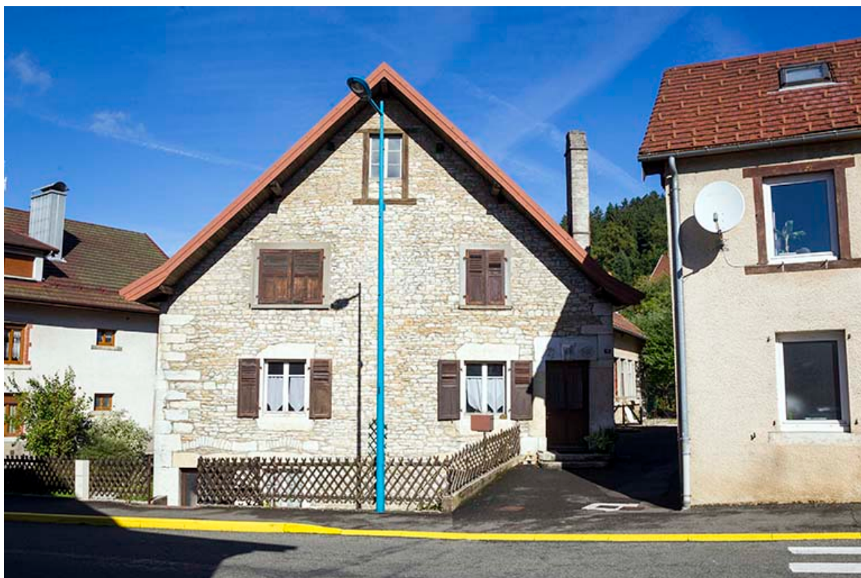
Maison : façade antérieure.
