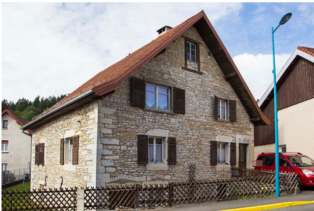
Maison : façades antérieure et latérale gauche.
