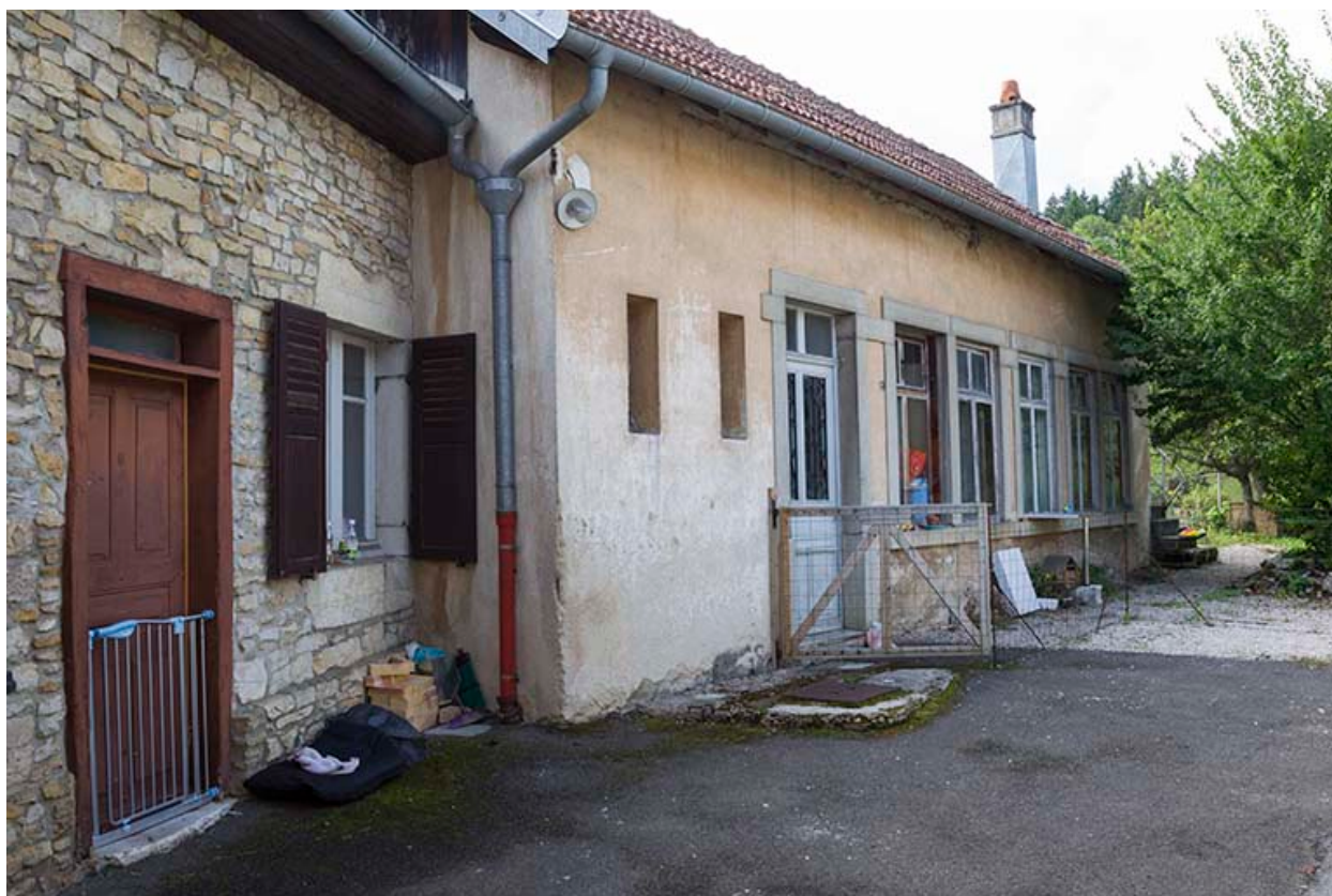
Usine : façade antérieure, de trois quarts gauche.
