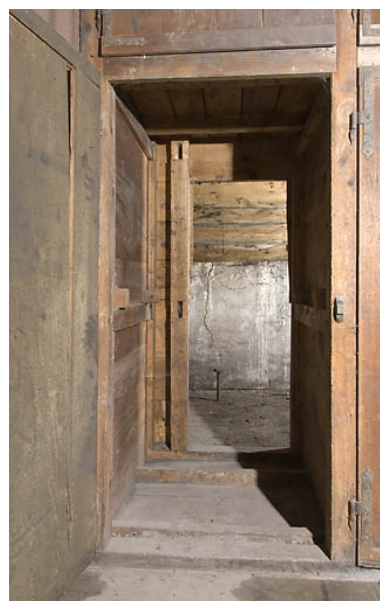
Usine, magasin industriel : placard ouvert. Phot. Jérôme Mongreville IVR43_20082501139NUC2A
