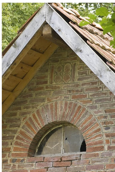
Remise : fenêtre et date. Phot. Jérôme Mongreville IVR43_20082501152NUC2A
