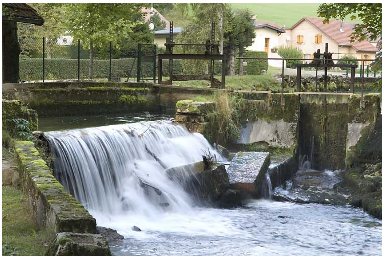
Canal d'amenée : vannes et déversoir.
