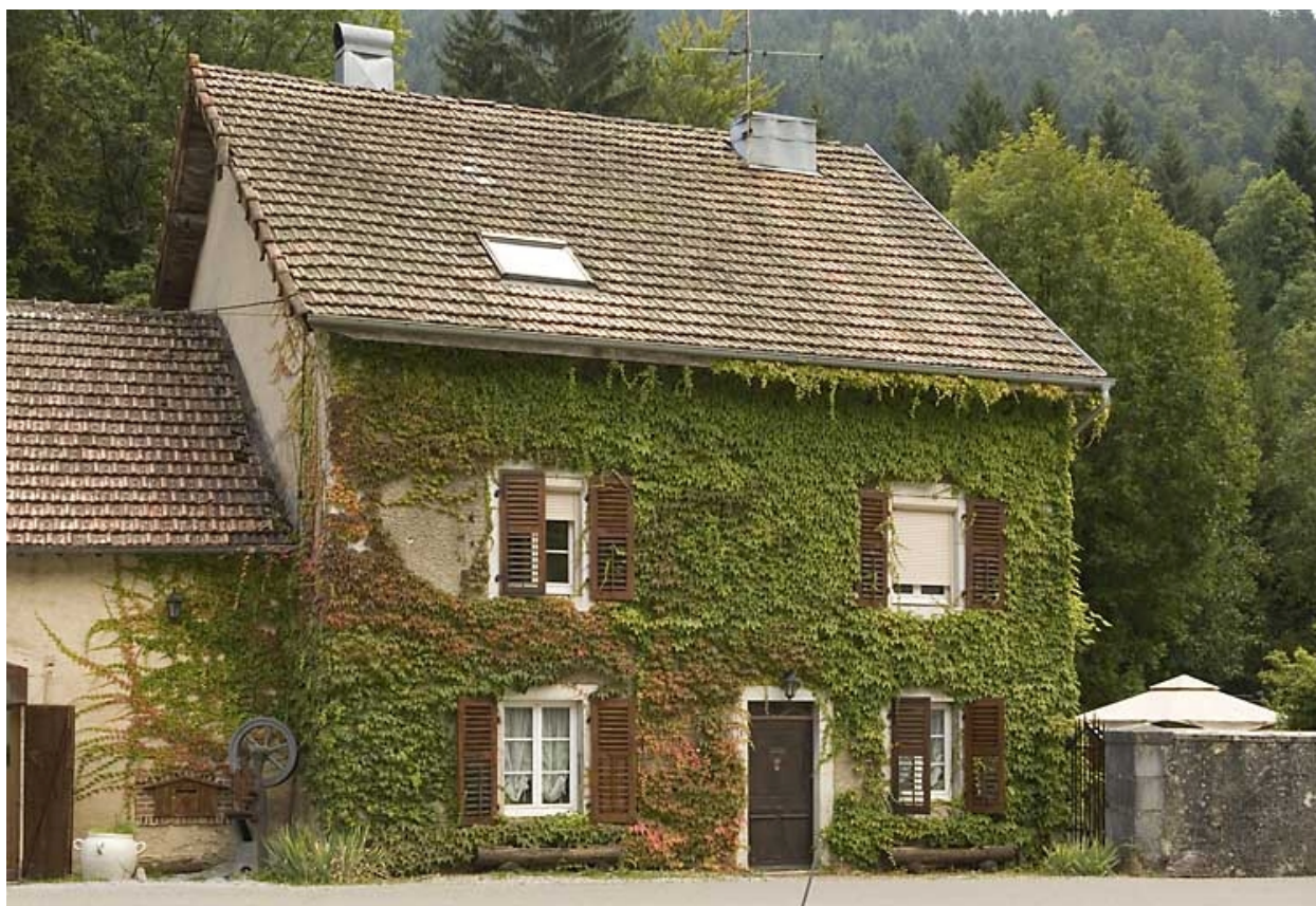
Maison : façade antérieure.
