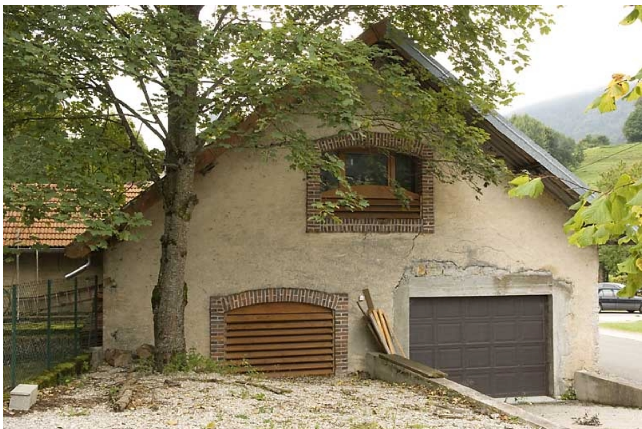
Usine : façade latérale gauche.
