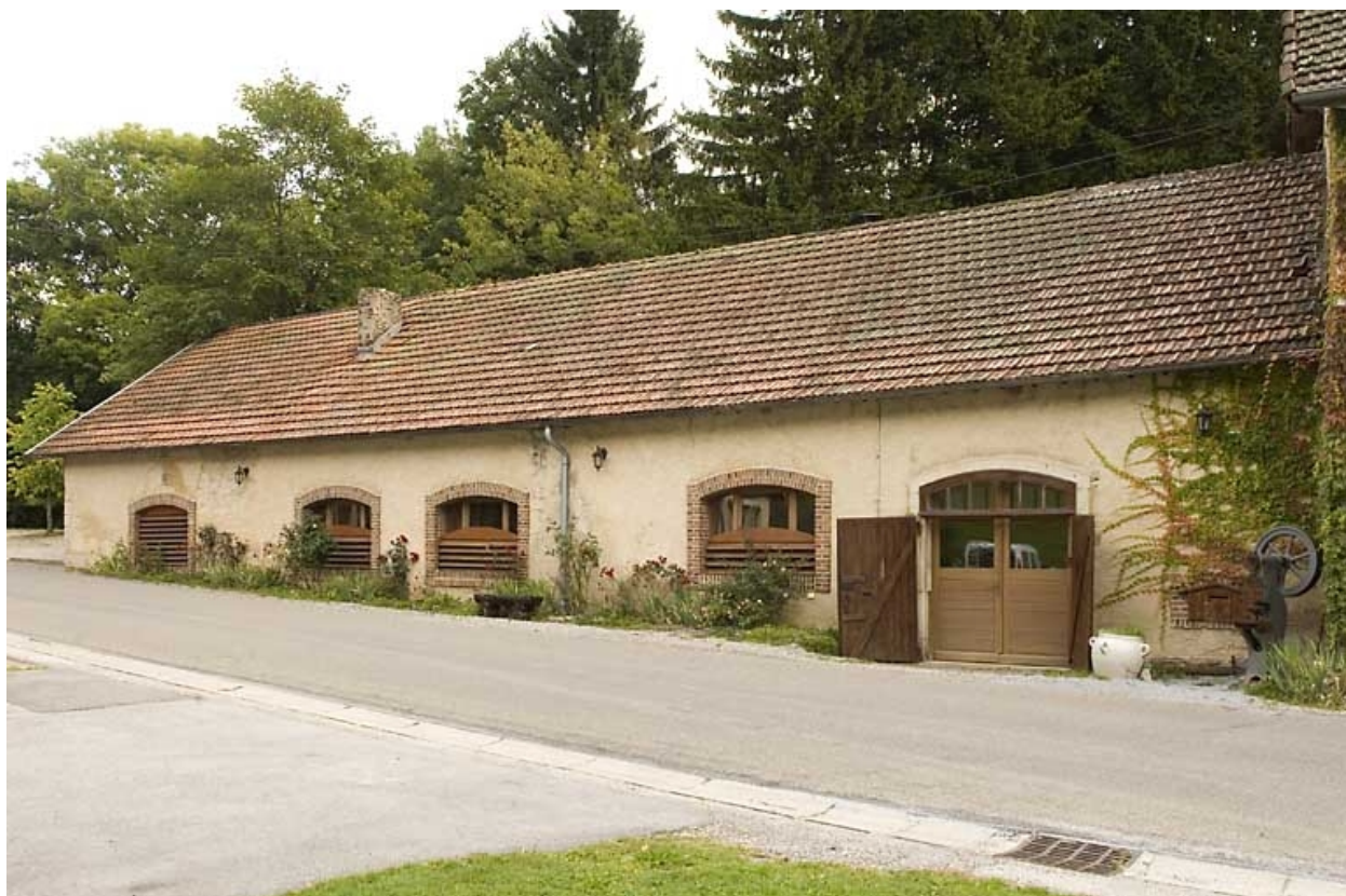
Usine, de trois quarts droite.
