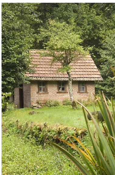
Remise : vue d'ensemble, depuis le sud. Phot. Jérôme Mongreville IVR43_20082501155NUC2A
