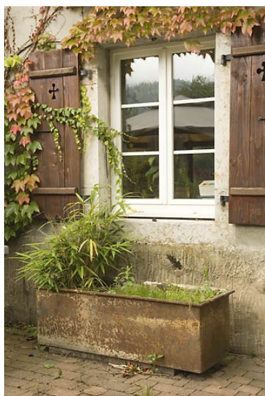
Maison, façade latérale droite : droite : fenêtre. Phot. Jérôme Mongreville IVR43_20082501153NUC2A
