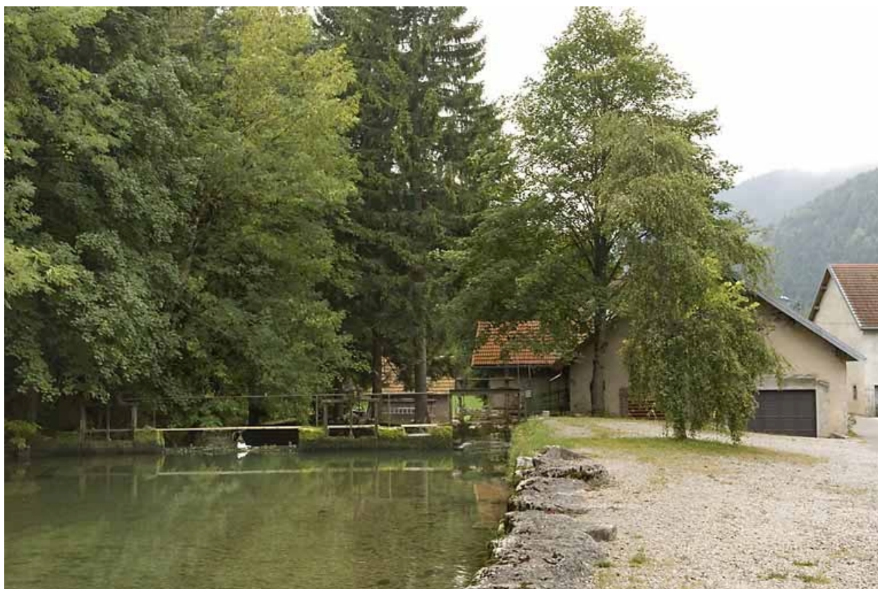
Canal d'amenée, depuis l'amont.
