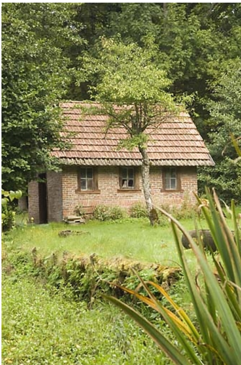
Remise : vue d'ensemble, depuis le sud.
