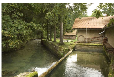
Canal d'amenée (avec déversoir à gauche) et bâtiment d'eau. Phot. Jérôme Mongreville IVR43_20082501158NUC2A
