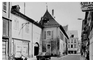
Ensemble de l'aile ouest avant démolition, vers 1950-1960.
