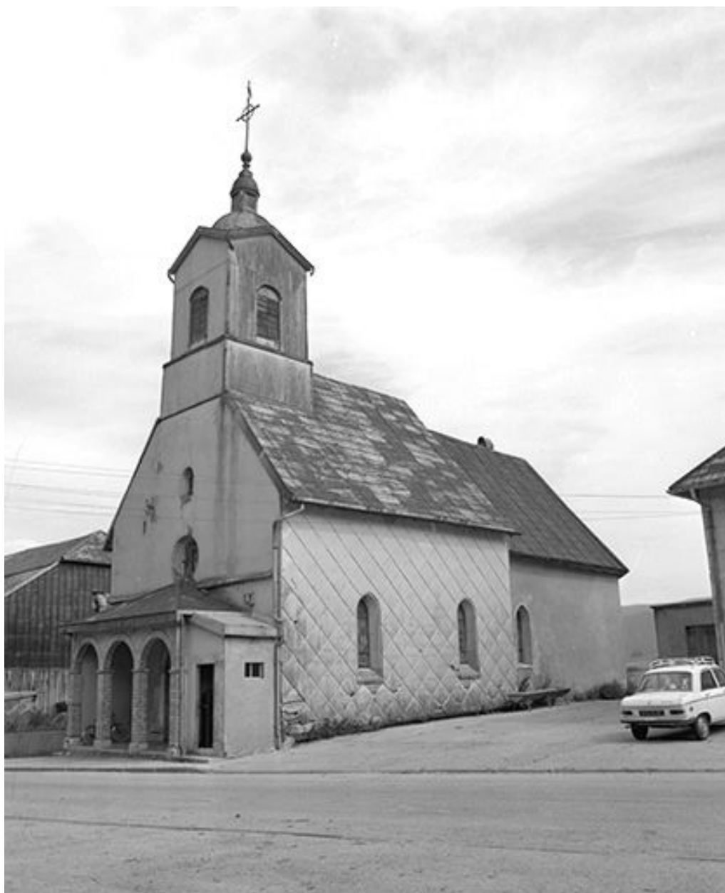
Façades antérieure et latérale droite.
