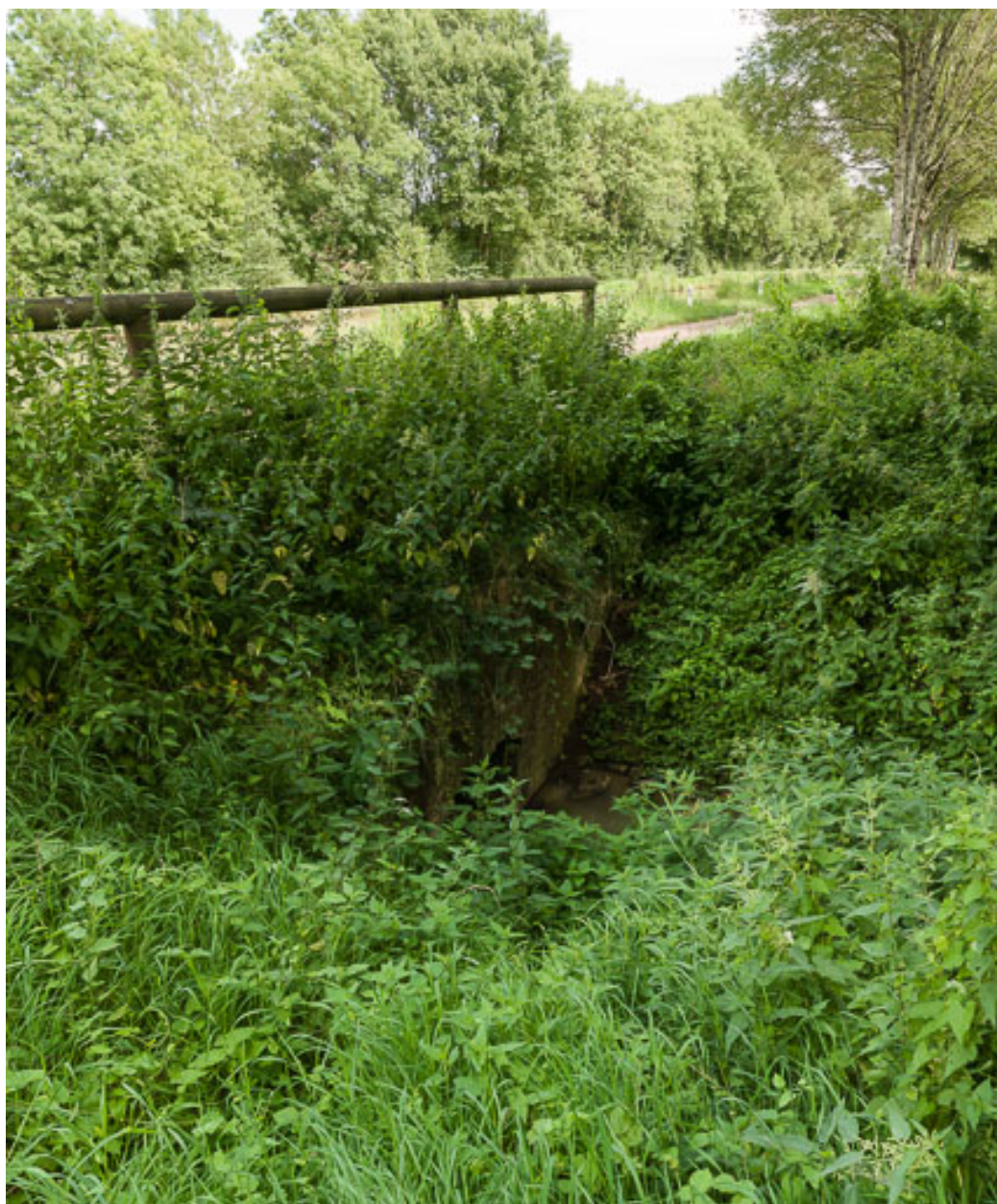
Vue de l'aqueduc.
