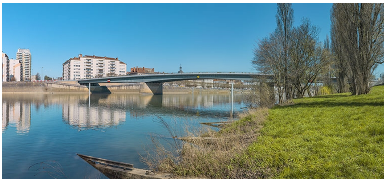
Vue d'ensemble du pont, prise d'aval.
