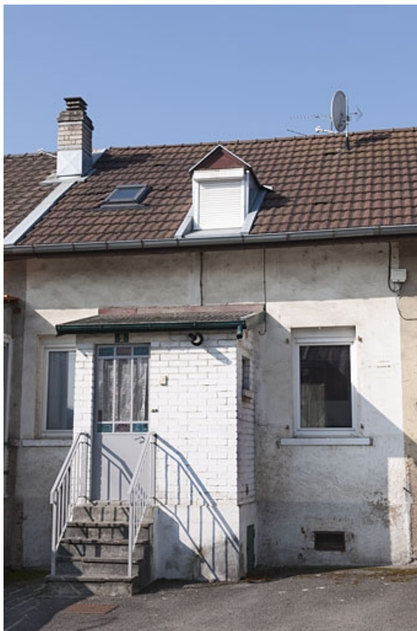
Détail d'une travée d'une habitation à 4 logements.
