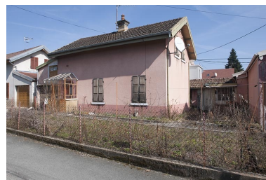
Maison individuelle rue des Lilas. Phot. Jérôme Mongreville IVR43_20122500226NUC4A
