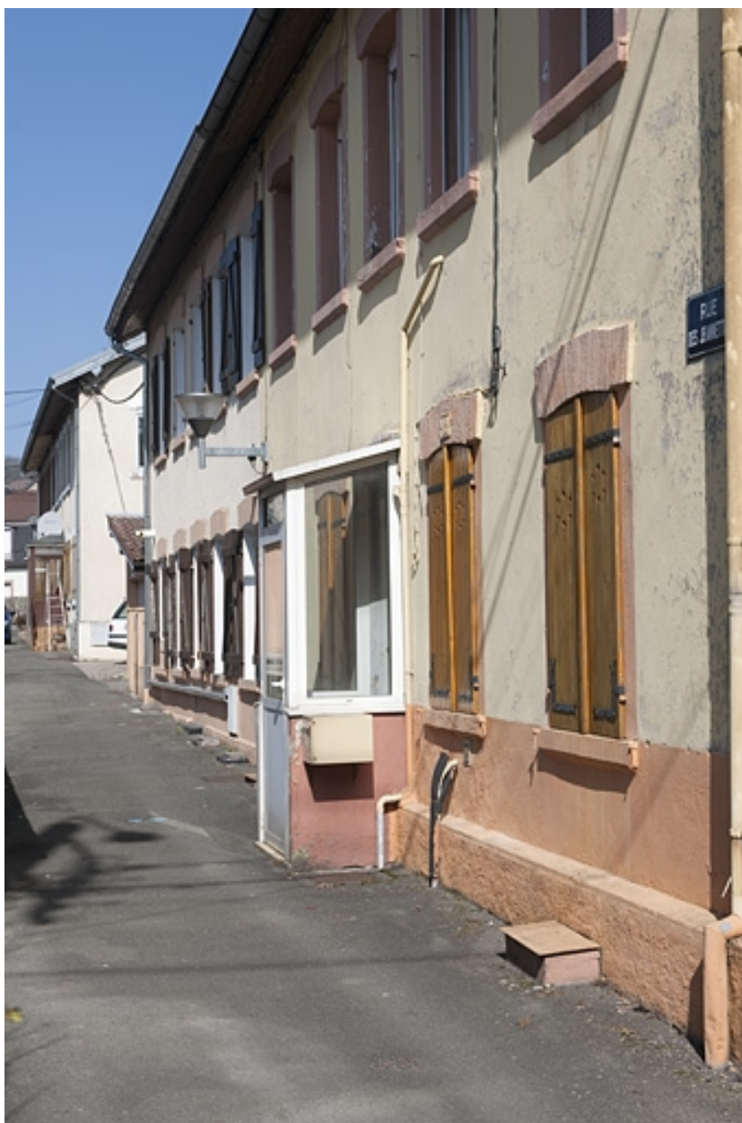
Détail d'une façade d'une habitations à 8 logements.
