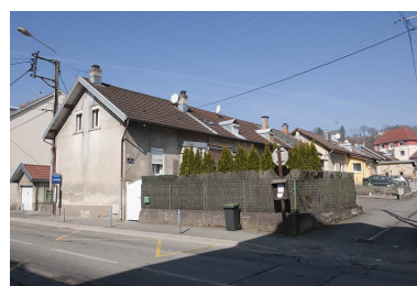
Habitations à 4 logements rue des Lilas. Phot. Jérôme Mongreville IVR43_20122500224NUC4A
