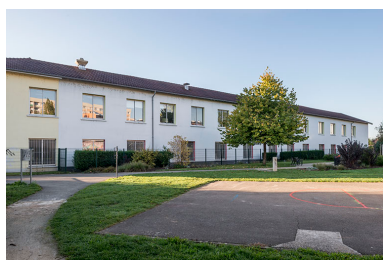
Façade nord de l'agrandissement (milieu 20e siècle).
