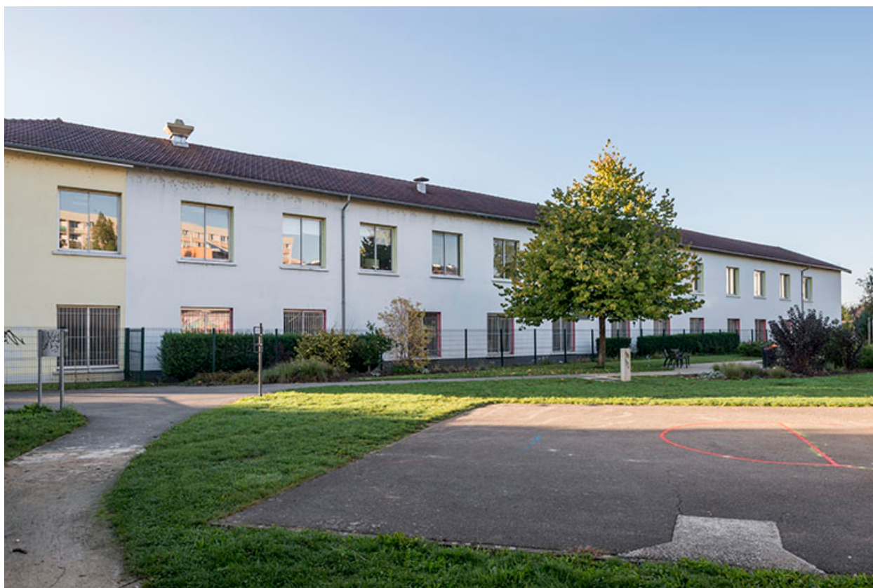
Façade nord de l'agrandissement (milieu 20e siècle).
