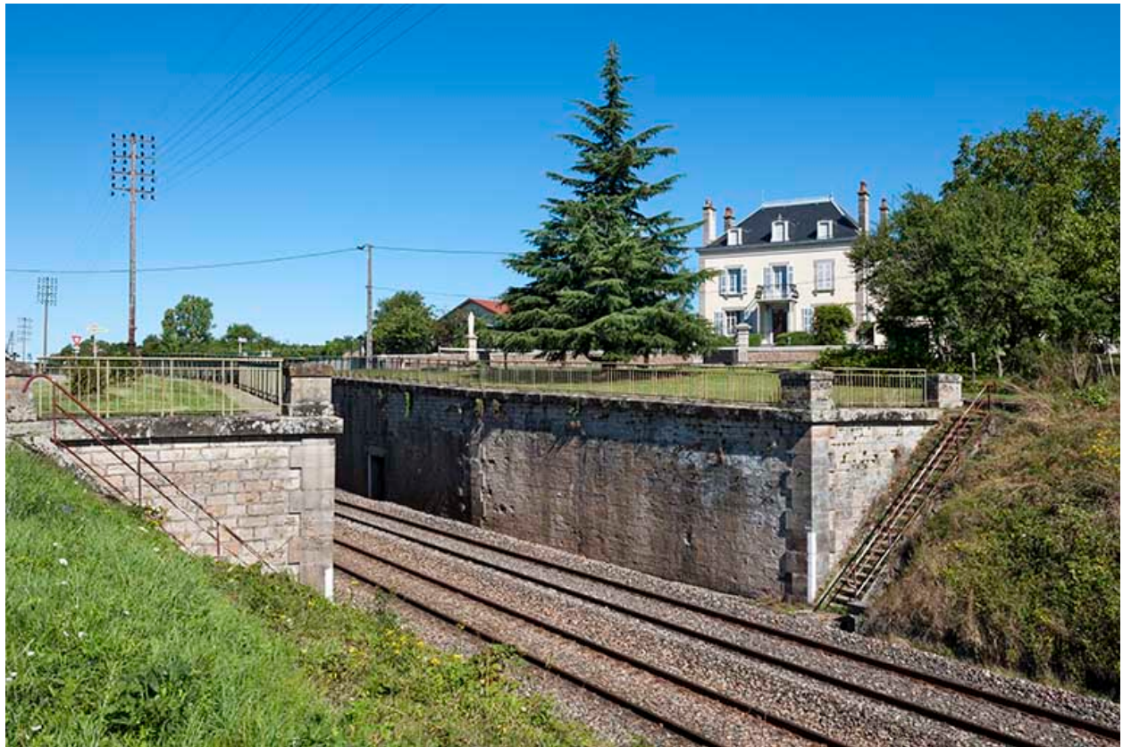
Voie ferrée traversant le village
