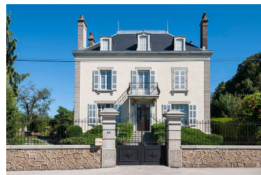
Maison 11 Grande rue, façade sur la rue et portail d'entrée. Phot. Jérôme Mongreville IVR43_20167001376NUC4A
