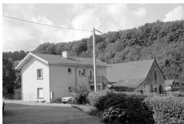
Logement et fromagerie. Phot. Laurent Poupard IVR43_19923901279Z
