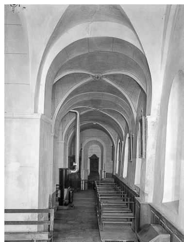
Intérieur : collatéral gauche. Phot. Yves Sancey IVR43_19743901114V
