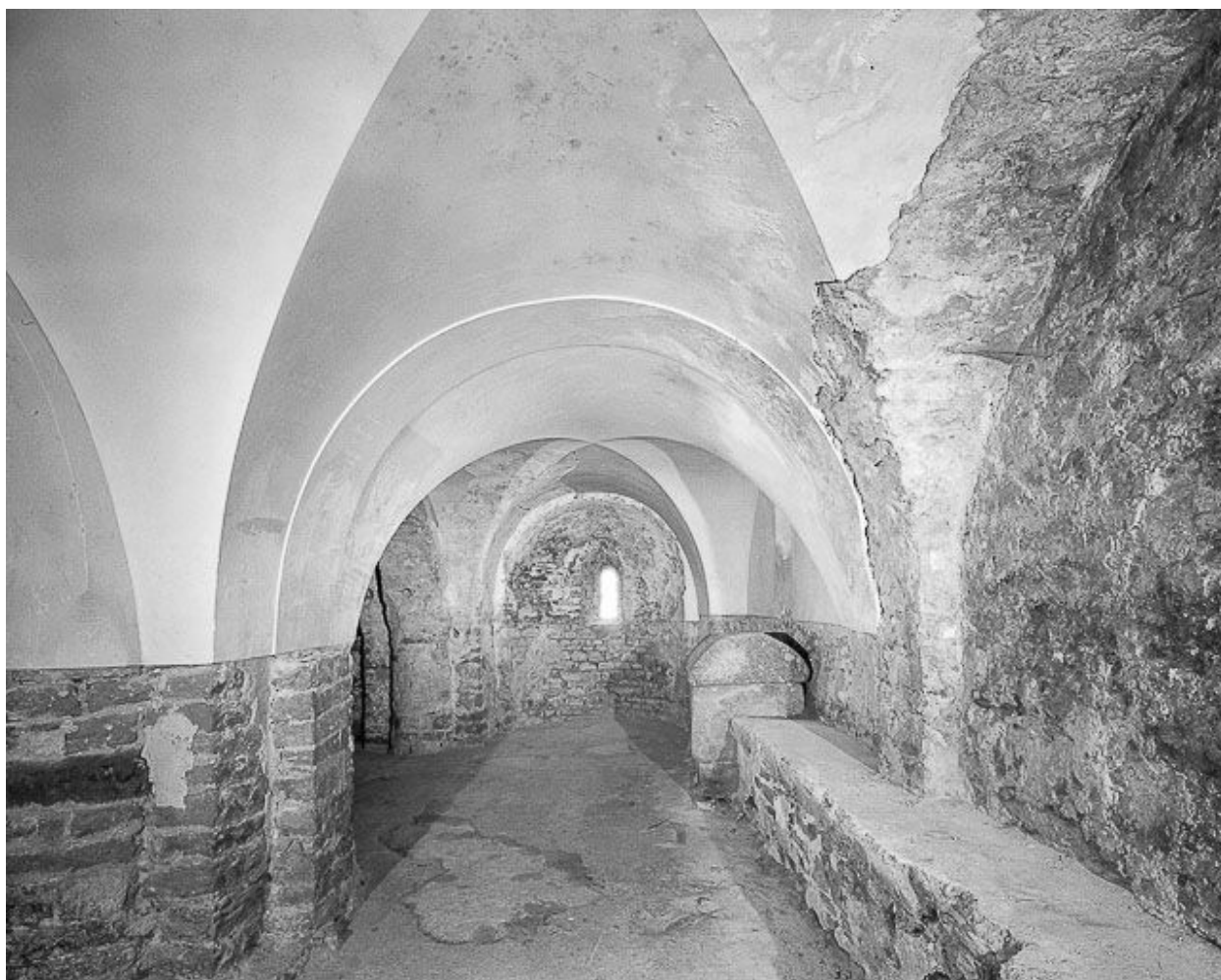
Intérieur : crypte, vaisseau droit vu depuis l'ouest.
