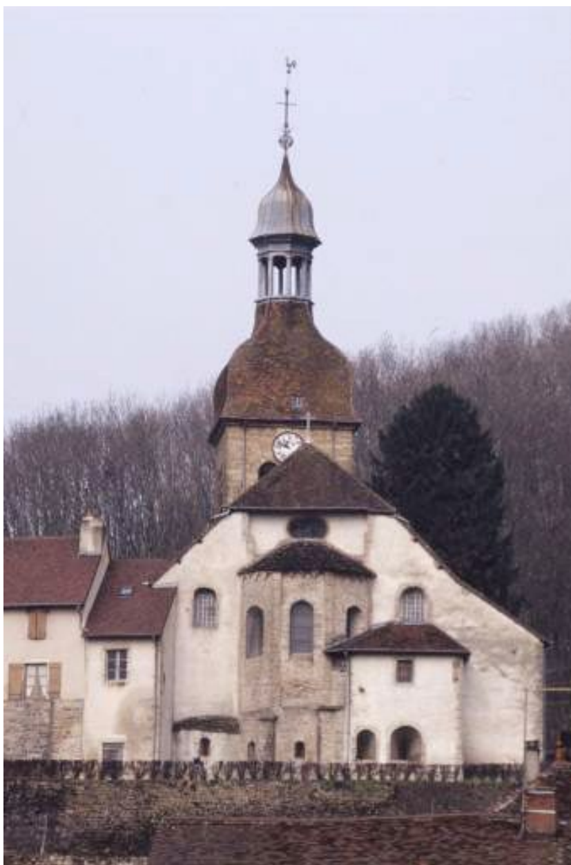
Vue générale du chevet de l'église.
