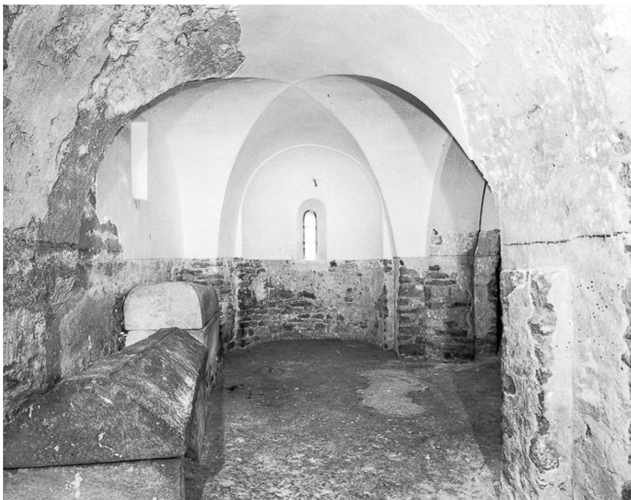
Intérieur : crypte, vaisseau gauche vu depuis l'ouest.
