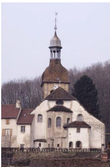
Vue générale du chevet de l'église. Phot. Yves Sancey IVR43_20003900029ZA
