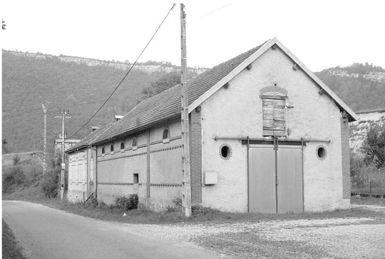
Les dépendances agricoles vues depuis la route.
