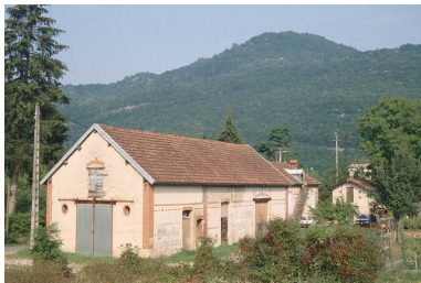
Les dépendances agricoles. Phot. Laurent Poupard IVR43_19903900501ZA
