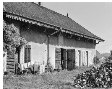
Maison cadastrée AC 251 : façade postérieure.
