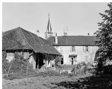
Maison cadastrée AC 251 : façade antérieure.
