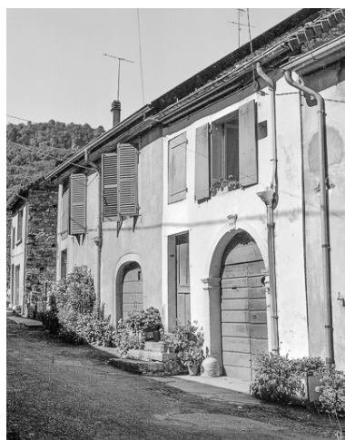
Fermes : façades sur rue. Phot. Dominique Dominguez IVR43_19803900217X
