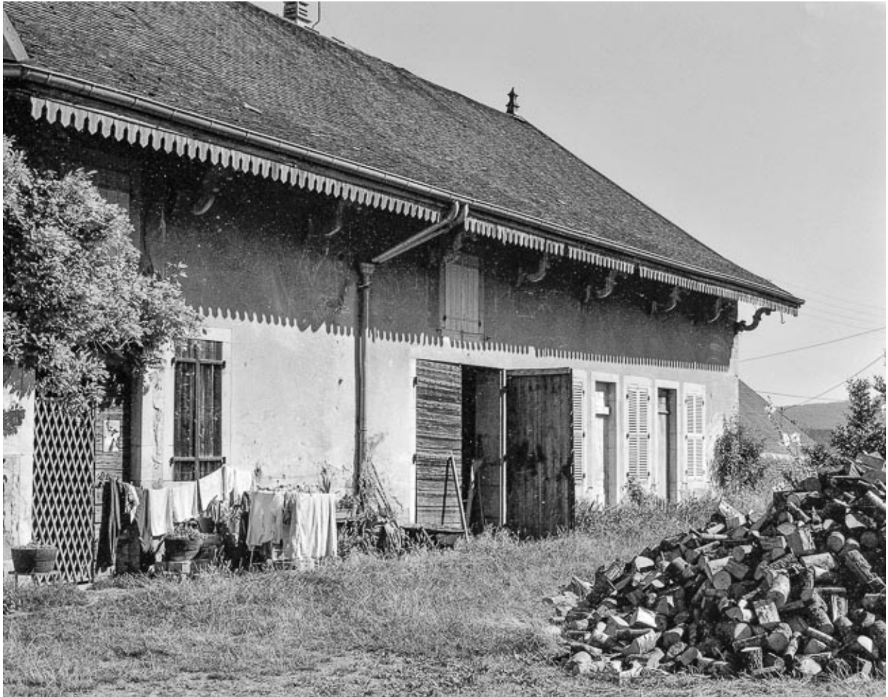
Maison cadastrée AC 251 ; façade postérieure.
