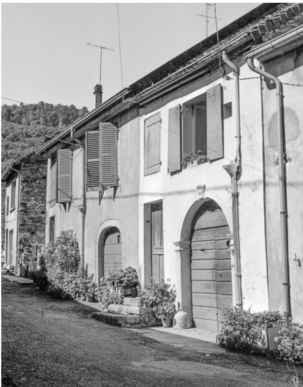
Fermes : façades sur rue.
