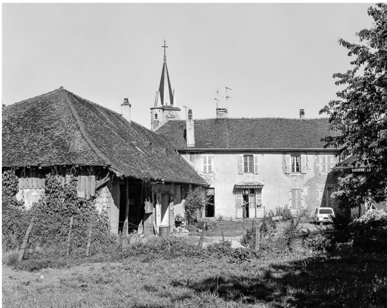
Maison cadastrée AC 251 : façade antérieure.
